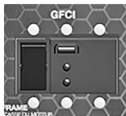
Figure 2-8. Test du DDFT
