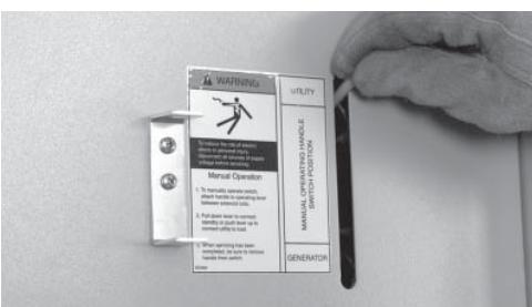
4. Repérer la manette de transfert et insérer l'extrémité métallique dans la fente de l'ensemble contacteur principal. Tirer la poignée vers le BAS pour déplacer les contacts principaux sur la position alimentation de secours (générateur).
