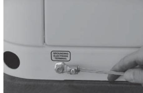
6. Connecter une tresse de masse approuvée à la cosse de masse sur le cadre du socle et à une masse à la terre approuvée ou à la barrette de mise à la terre comme spécifié par les règlements locaux.
