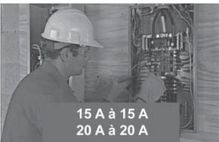
8. Avec des connecteurs de fils homologués UL, rebrancher le fil d'alimentation à un disjoncteur apparié dans le commutateur convertisseur.
