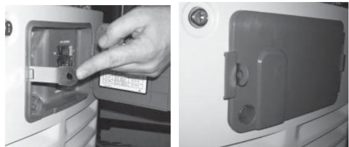
5. Pour les modèles 10 à 20 kW, repérer le fermoir de sûreté en métal qui se trouve dans le sac du manuel du propriétaire. Insérer le fermoir dans la fente située sur le côté gauche de la boîte de disjoncteurs externe. S'assurer que le clip du fermoir est tourné vers le devant de la génératrice. Verrouiller la boîte externe si on le désire.
