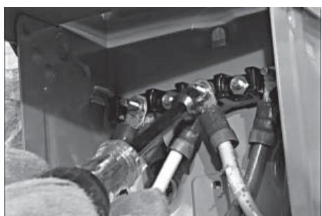
3. Monter la boîte de connexion de façon à ce qu'elle couvre complètement le trou dans le mur. Calfeutrer autour des côtés et du dessus de la boîte pour bien sceller.
