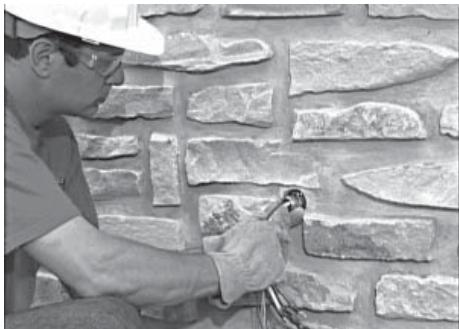
1. Percer un trou de 1 ¾ po et faire passer le conduit dans le trou.
