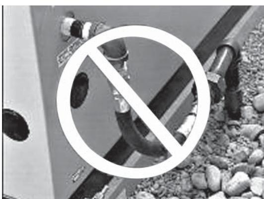
5. Ne jamais plier un tuyau de carburant flexible pour éviter d'utiliser un coude. Plier le tuyau flexible réduit sa capacité d'absorption des vibrations et va à l'encontre du but recherché tout en restreignant le débit de carburant.
