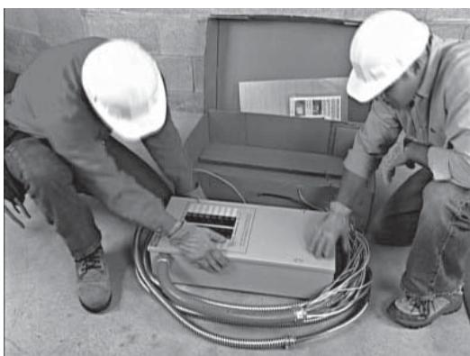
2. Toujours inspecter le commutateur pour dommages pendant le transport. Ne jamais monter un commutateur converteur qui semble endommagé.
