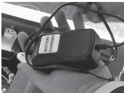
1. Si la génératrice vient avec un chargeur de batterie dans un emballage séparé, il sera peut être nécessaire d'installer le chargeur, soit dans la génératrice soit dans le commutateur convertisseur. Voir la documentation comprise dans le chargeur de batterie pour installer et câbler le chargeur de batterie.
