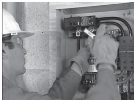
1. Brancher les fils d'alimentation de la génératrice et du secteur aux bornes appropriées du commutateur convertisseur. Les bornes sont clairement marquées dans le commutateur.
