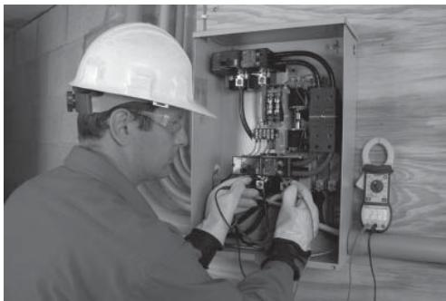
8. Pour tous les modèles, sauf le 8 et le 10 kW, vérifier que la tension et la fréquence de la génératrice sont correctes. Si la tension ligne à ligne n'est pas d'environ 240 volts, voir le manuel du propriétaire de la génératrice pour les procédures correctes de réglage. Sur tous les modèles, si la tension ligne à neutre n'est pas d'environ 120 volts, vérifier la connexion neutre entre la génératrice et le commutateur convertisseur.
