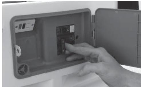
12. Mettre le disjoncteur principal de la génératrice sur ON et mettre le commutateur de mode sur AUTO.
