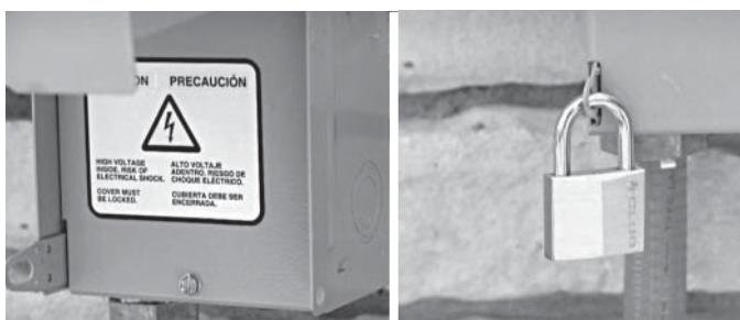
4. Remettre la plaque de couvercle protectrice et la vis de fixation puis verrouiller la boîte de connexion.
