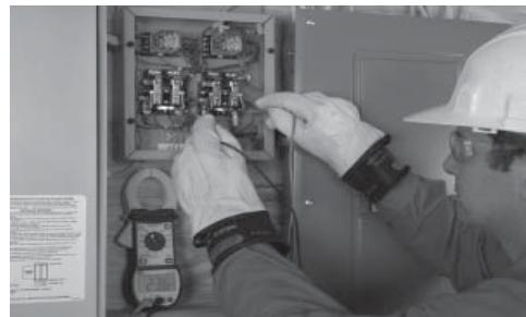
5. Quand la génératrice porte toute la charge, vérifier la tension sur le côté charge des contacteurs pour s'assurer que les appareils branchés directement au contrôleur fonctionnent correctement.
