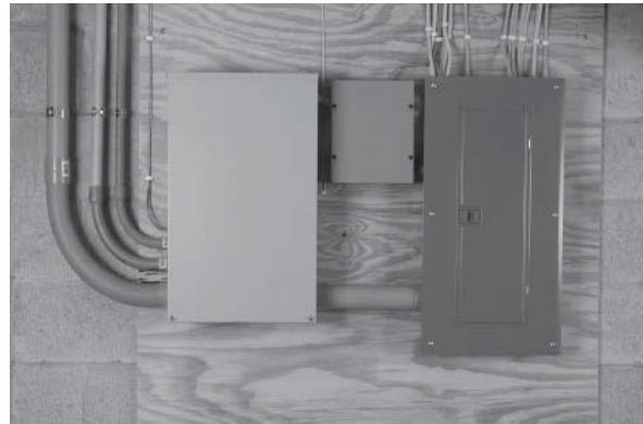
1. Le contrôleur de charge PowerMaster doit être monté aussi près du panneau principal de distribution que possible pour éviter un épissurage. Voir les instructions et le diagramme de câblage dans le manuel technique PowerMaster avant de commencer l'installation.
