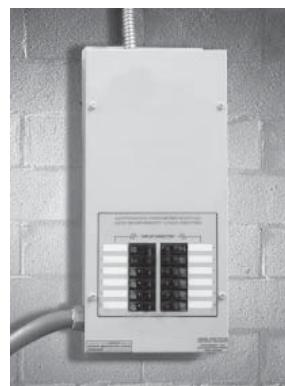
2. Pour les applications avec un commutateur Centre de Charge RTS, le chargeur a déjà été installé dans le commutateur convertisseur.
