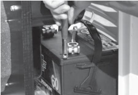
2. Suivre toutes les procédures et respecter toutes les précautions de sécurité du manuel du propriétaire de la génératrice quand on installe la batterie. Vérifier que l'interrupteur est en position arrêt lors de la préparation du test de fonctionnement, NE PAS brancher la batterie avant que les connexions du commutateur convertisseur soient finies.
