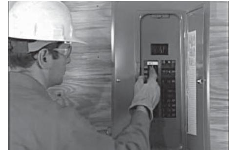
7. S'assurer que le disjoncteur à 2 pôles installé dans le panneau de distribution principal est en position OFF.
