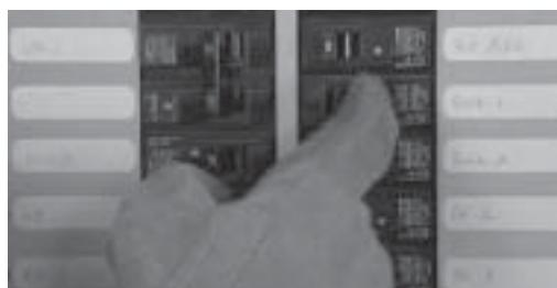
12. Une fois que le moteur a terminé son cycle de refroidissement et s'est arrêté, arrêter à nouveau l'alimentation secteur. Quand la génératrice fournit du courant au commutateur convertisseur, mettre les disjoncteurs dans le commutateur en position ON, un à la fois, jusqu'à ce que la génératrice ait accepté la charge prioritaire tout entière.
