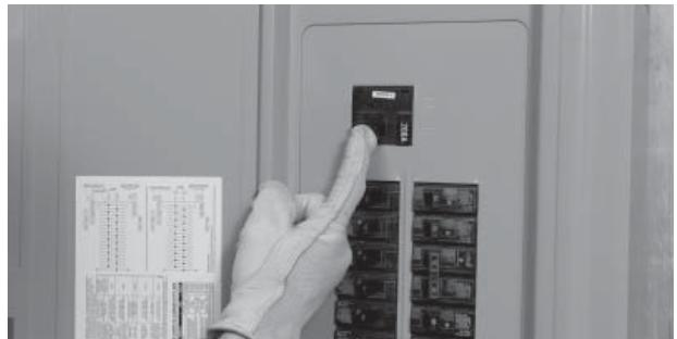
20. Fermer le disjoncteur pour restaurer le courant secteur et permettre au moteur de se refroidir et de s'arrêter. Les tests de fonctionnement sont maintenant terminés. Voir – Régler la fonction Automatic Exercise pour finir l'installation.
