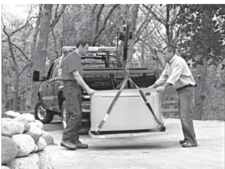
4. S'assurer que le matériel de levage à utiliser possède une capacité suffisante pour soulever sans danger le poids de la génératrice. Utiliser des sangles de levage et les brancher aux orifices de levage à chaque coin du socle pour éviter d'endommager le boîtier.
