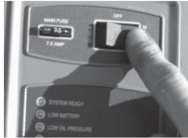
4. Mettre l'interrupteur de mode de la génératrice sur MANUAL (manuel) pour faire démarrer le moteur. Permettre au moteur de chauffer puis mettre le disjoncteur principal de la génératrice en position ON (marche). La génératrice fournit maintenant de l'électricité au commutateur convertisseur mais ne porte aucune charge.
