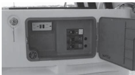
7. Pour tous les autres modèles, le disjoncteur est attaché au panneau d'accès extérieur.
