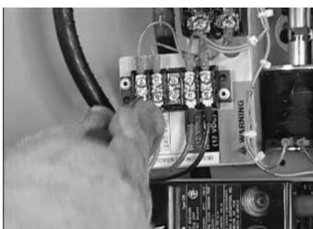
3. Brancher les fils de commande de la génératrice au bloc de jonction dans le commutateur convertisseur. Les bornes sont clairement marquées N1, N2, 23 et (194 ou 15B). Si la quatrième borne dans le commutateur convertisseur est marquée 194, le fil 15B de la génératrice se branche à la borne 194 dans le commutateur convertisseur.
