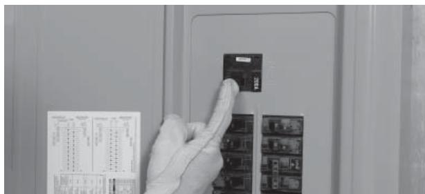
11. Si tout fonctionne correctement, mettre le disjoncteur sur ON et s'assurer que le courant est automatiquement renvoyé au secteur.
