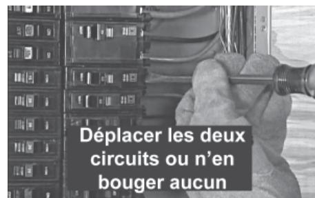
5. Quand on utilise un câblage à trois conducteurs, deux circuits de 120 volts partageront souvent le même fil neutre. Pour éviter de surcharger le neutre, soit déplacer les DEUX circuits qui partagent le neutre soit n'en bouger aucun.
