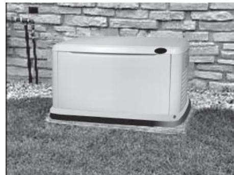
5. Poser la génératrice sur la plate-forme de façon à ce que le lit de gravier dépasse de plusieurs pouces la génératrice sur tous les côtés. S'assurer que la génératrice est à niveau à 1,3 cm (½ po) près.
