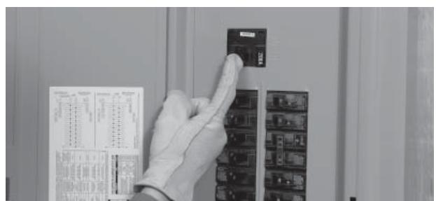
14. Mettre le disjoncteur principal sur ON pour restaurer le secteur. La génératrice continuera à fonctionner pour permettre au moteur de se refroidir avant de s'arrête. Éteindre encore le courant au secteur. La génératrice devrait se mettre en route et la charge prioritaire devrait se transférer à la génératrice. Fermer le disjoncteur pour restaurer le courant secteur et permettre au moteur de se refroidir et de s'arrêter.
