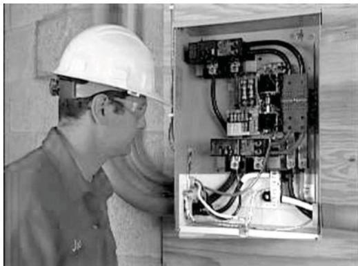
2. La mise à la terre, normalement dans le panneau principal, doit être accomplie dans un interrupteur de secteur et doit être débranchée dans le panneau de distribution existant. Voir le Code National d'Électricité (NEC) pour informations complètes sur la mise à la terre et le collage. L'interrupteur de service séparé n'est pas montré dans les étapes suivantes mais est installé entre le compteur et le commutateur convertisseur.
