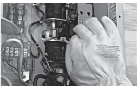
3. Repérer la manette de transfert, insérer l'extrémité métallique dans la fente du contacteur principal et tirer la manette vers le BAS pour déplacer les contacts principaux sur l'alimentation de secours, la position génératrice.
