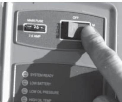
7. Mettre l'interrupteur de mode de la génératrice sur MANUAL (manuel) pour faire démarrer le moteur.
