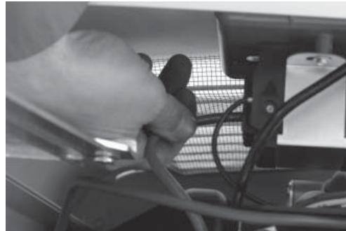
4. Faire passer les fils dans le dos de la génératrice et fixer le conduit à l'aide du contre-écrou.
