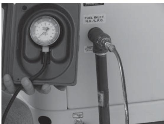
6. Après avoir vérifié s'il y a des fuites, vérifier la pression de gaz au raccord en T installé auparavant pour s'assurer qu'il y a assez de pression pour le fonctionnement correct de la génératrice.
