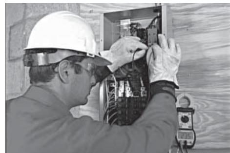
5. Pour tous les modèles, sauf le 8 et le 10 kW, vérifier que la tension et la fréquence de la génératrice sont correctes. Si la tension ligne à ligne n'est pas d'environ 240 volts, voir le manuel du propriétaire pour les procédures correctes de réglage. Sur tous les modèles, si la tension ligne à neutre n'est pas 120 volts, vérifier la connexion neutre entre la génératrice et le commutateur convertisseur.
