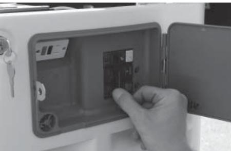
1. Mettre le disjoncteur principal de la génératrice sur OFF (arrêt) et mettre l'interrupteur de mode sur la position OFF.
