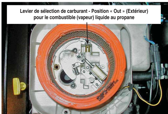
Schéma 1.8 - GT-990/ GT-999, 14, 17 et 20 kW (couvercle de boîte à vent retiré)
