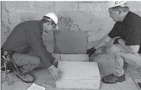
2. Siempre inspeccione el interruptor si tiene daños por el embarque. Nunca monte un interruptor de transferencia que muestre alguna evidencia de daño.
