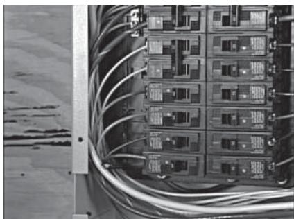
4. Cada cable en el interruptor de transferencia pre cableado está codificado en color para emparejarse fácilmente en el panel principal con sus nuevos interruptores en el interruptor de transferencia.
