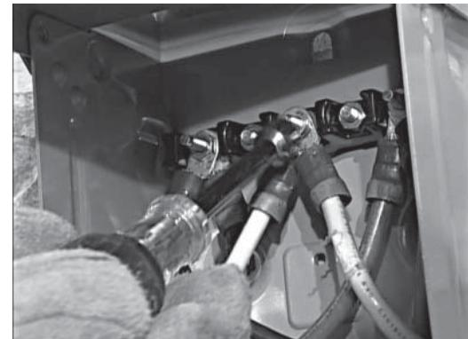
2. Retire la tapa rebatible detr s de la caja de conexiones, aliente los cables a trav s de la parte deatr s de la caja y asegure al conducto con la tuerca de cierre. Selle el agujero con masilla de silicona. No olvide enmasillar el agujero dentro de la caja tambi n.
