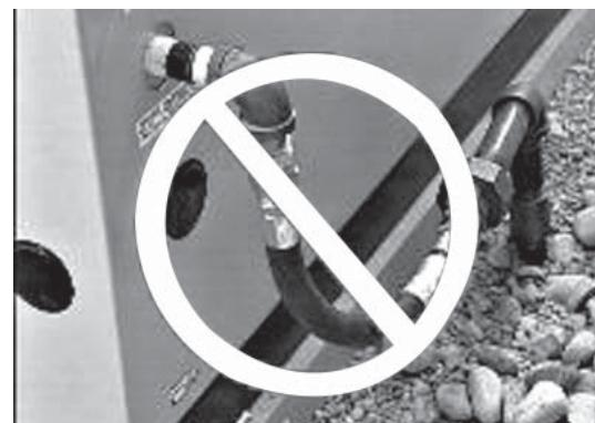
5. Nunca doble la línea flexible de combustible para evitar usar un codo. El doblar una línea flexible disminuye su capacidad de absorber vibraciones y frustra su propósito así como construye su flujo real de combustible.
