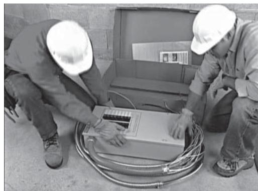
2. Siempre inspeccione el interruptor si tiene daños por el embarque. Nunca monte un interruptor de transferencia que muestre alguna evidencia de daño.
