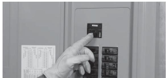
10. Apague la energía pública y asegúrese que el generador arranque automáticamente.
