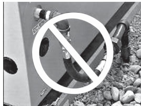
5. Ne jamais plier le tuyau flexible de carburant afin d'éviter d'utiliser un coude. Le fait de plier le tuyau flexible réduit sa capacité à absorber les vibrations, contrarie son objectif et comprime le débit actuel.
