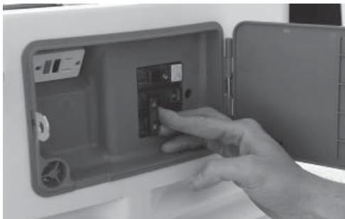
12. Placer le disjoncteur principal du générateur sur la position ON (Marche) et le sélecteur de mode sur la position AUTO.
