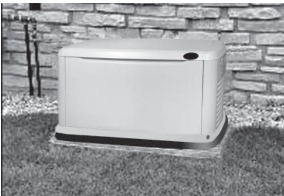
1. Si le générateur est équipé d'une boîte de jonction externe et d'une lanière étanche de 5 pieds précâblée et connectée au générateur, aucun branchement supplémentaire n'est nécessaire sur le générateur. Sauter la section suivante et passer à l'Annexe A, Installation et test opérationnel du commutateur EZ.
