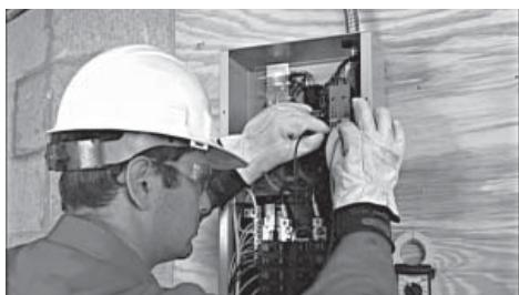
5. Asegúrese de que el voltaje y la frecuencia del generador sea correcta. Si el voltaje de línea a línea no es aproximadamente 240 voltios, consulte los procedimientos apropiados de ajuste en el manual del propietario. En todos los modelos, si el voltaje de línea a neutro no es 120 voltios, revise las conexiones de neutro entre el generador y el interruptor de transferencia.
