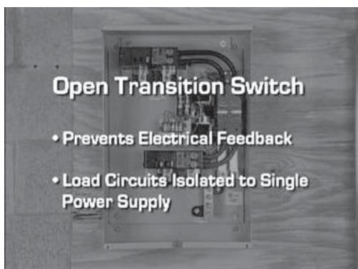
6. Le commutateur de transfert utilisé est un commutateur à coupure. Le commutateur à coupure empêche la rétroaction divergente électrique entre le générateur et le réseau public en permettant seulement aux circuits de charge d'être connectés à une seule alimentation à la fois.
