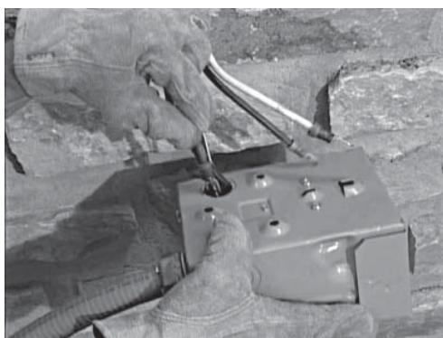
2. Retirer la débouchure de l'arrière de la boîte de jonction, alimenter les fils à travers l'arrière de la boîte et fixer le conduit à l'aide d'un contre-écrou. Sceller le trou avec de la pâte de silicone.
