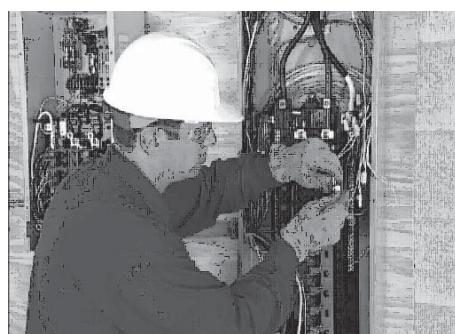
9. S'assurer que chaque circuit déplacé est protégé par un disjoncteur de même taille sur le commutateur de transfert. Les circuits de 15 A doivent être connectés à des disjoncteurs de 15 A et les circuits de 20 A à des disjoncteurs de 20 A.
