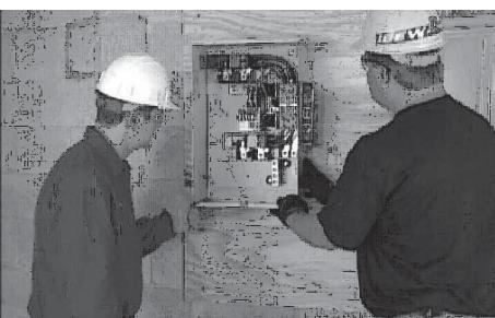
3. Protéjalo contra impactos y Monte el interruptor verticalmente a una estructura de soporte rígida. Asegúrese de que el interruptor esté nivelado y a plomo. Revise los códigos locales antes de cablear el interruptor de transferencia. Algunas jurisdicciones requieren que el cableado dentro del interruptor sea hecho por un electricista licenciado.
