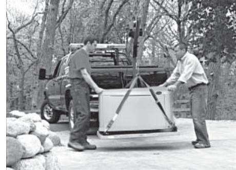
4. Asegúrese de que el equipo de elevación a usarse tenga la suficiente capacidad para manejar en forma segura el peso del generador. Use cuerdas de elevación de nylon y conéctelas a los ojales de elevación en cada esquina del marco de la base para evitar daños en la caja.
