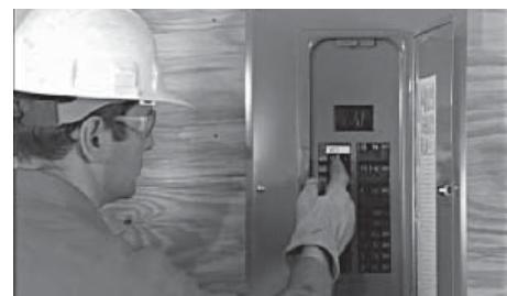
7. Asegúrese de que el interruptor de circuito de 2 polos instalado en el panel de distribución principal esté en la posición OFF.
