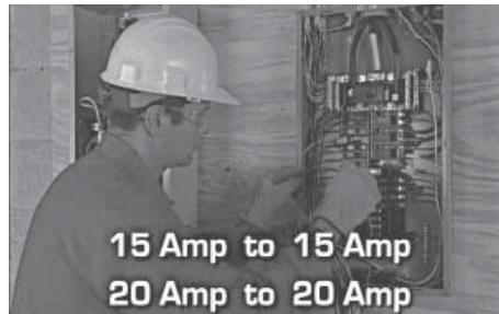
8. À l'aide de coincideurs à câble homologués UL, reconnecter le fil d'alimentation à un disjoncteur correspondant du commutateur de transfert.
