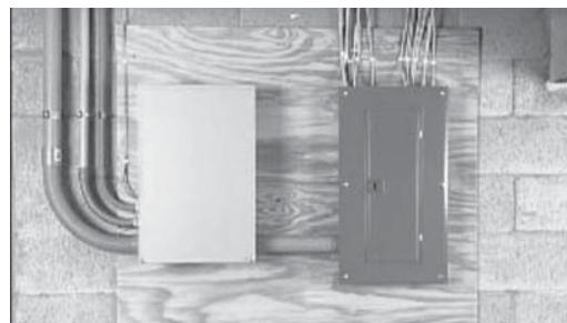
1. Antes de emprezar cualquier instalación, asegúrese que la energía esté apagada al panel de distribución principal y lea cuidadosamente el manual del propietario que vino con el interruptor de transferencia. Para simplificar el proceso de instalación, el interruptor de transferencia deberá montarse lo más cerca posible del panel de distribución principal. Asegúrese de que no gotee agua ni sustancias corrosivas en la caja del interruptor de transferencia.
