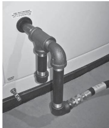
4. Lors du raccordement de la canalisation de gaz au générateur, utiliser la partie fournie du tuyau flexible de carburant certifié UL ou approuvé AGA conformément aux réglementations locales. Le tuyau flexible de carburant sert à s'assurer que les vibrations provenant du générateur ne causent pas de fuite de gaz au niveau de l'un des points de raccordement, il est donc important que le tuyau soit installé avec peu de coude si possible.
