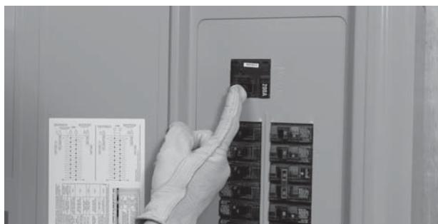
20. Fermer le disjoncteur pour rétablir l'alimentation du réseau public et laisser le moteur se refroidir et s'arrêter automatiquement.
