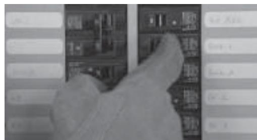
12. Une fois que le moteur a réalisé son cycle de refroidissement et qu'il s'est arrêté, remettre le réseau public hors tension. Lorsque le générateur alimente le commutateur de transfert, déplacer les disjoncteurs du commutateur sur la position ON (Marche), un par un, jusqu'à ce que le générateur accepte la charge prioritaire complète.
