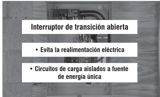
6. El interruptor de transferencia en uso es un interruptor de transición abierta. Los interruptores de transición abierta evitan la realimentación eléctrica entre el generador y el servicio público permitiendo sólo que los circuitos de carga se conecten a una fuente de energía a la vez.
