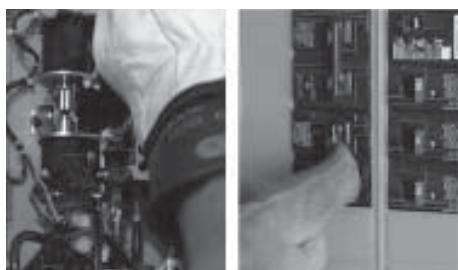
8. Utiliser la poignée de transfert pour déplacer les contacts principaux du commutateur de transfert vers la position UP (réseau public). Placer le disjoncteur bipolaire du panneau de distribution sur la position ON (Marche).
