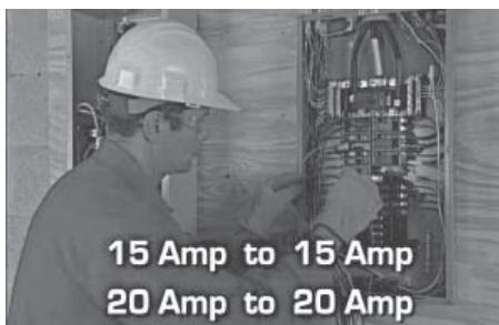
8. Usando tuercas de cable listadas UL, reconecte la punta de energía al interruptor apareado en el interruptor de transferencia.
