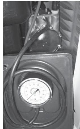
16. Le générateur portant la charge complète, reconstrôler la pression du gaz pour vérifier qu'elle se trouve au niveau auquel elle se situait avant le démarrage du générateur.
