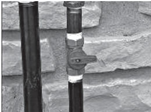
7. Après avoir vérifié la pression de gaz, fermer la soupape d'arrêt manuelle.
