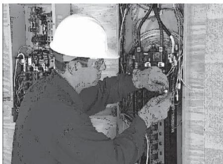
9. Asegúrese de que cada circuito movido esté protegido por el interruptor del mismo tamaño en el interruptor de transferencia. Circuitos de 15 amp deben conectarse a interruptores de 15 amperios y circuitos de 20 amps a interruptores de 20 amperios.
