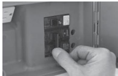
4. Apague el interruptor de circuito principal del generador y ponga el interruptor de modo en la posición OFF (apagado).
