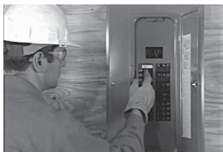
7. S'assurer que le disjoncteur bipolaire installé sur le panneau de distribution principale est placé sur la position OFF (Arrêt).
