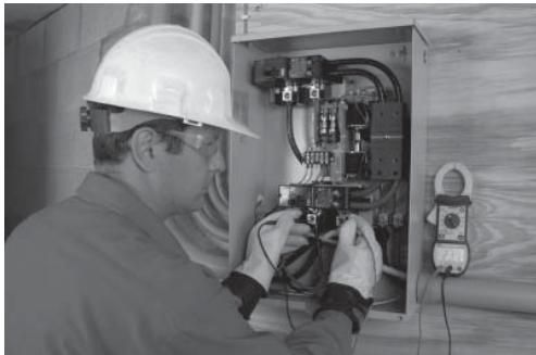
8. Asegúrese de que el voltaje y la frecuencia del generador sea correcta. Si el voltaje de línea a línea no es aproximadamente 240 voltios, consulte los procedimientos apropiados de ajuste en el manual del propietario. Si el voltaje de línea a neutro no es aproximadamente 120 voltios, revise las conexiones de neutro entre el generador y el interruptor de transferencia.
