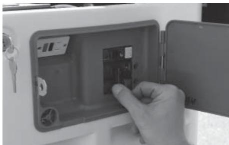
6. Une fois la vérification de la tension terminée, placer le disjoncteur principal du générateur et le sélecteur de mode sur la position OFF (Arrêt) pour éteindre le générateur.
