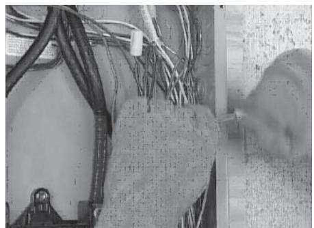
7. Choisir un circuit qui disposera d'un dispositif de secours et retirer le fil d'alimentation du disjoncteur.
