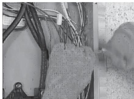
7. Elija un circuito a ser respaldado y retire la punta de energía del interruptor.
