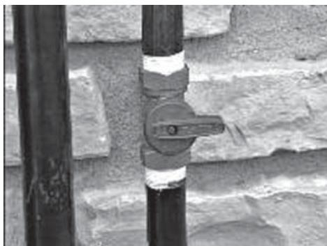
2. La plupart des applications nécessiteront une soupape d'arrêt manuelle externe sur le tuyau de carburant.
