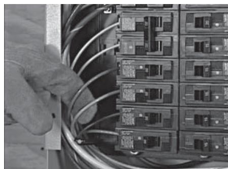
6. Al mover dos circuitos con un neutral compartido, deberán estar conectados a posiciones adyacentes (una sobre la otra) en el interruptor de transferencia. Eso asegurará que los dos cables calientes estén en fases separadas y mantendrán su relación con el neutral.
