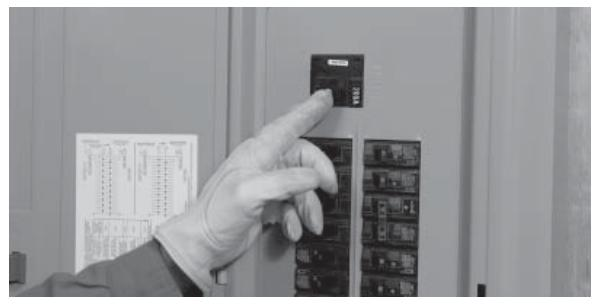
15. Remettre l'alimentation du réseau public hors tension pour démarrer automatiquement le générateur. Lorsque l'alimentation s'est transférée vers le générateur, fermer chaque disjoncteur du panneau de distribution, un par un, jusqu'à ce que le générateur accepte la charge complète.
