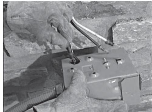
6. Despu s de comprobar que no haya fugas, revise la presi n del gas en el regulador para asegurarse de que no hay presi n de gas suficiente para la operaci n del generador. Consulte el manual del propietario para conocer las especificaciones de presi n de combustible. Si no es dentro de estos l mites, en contacto con su proveedor de gas local.
