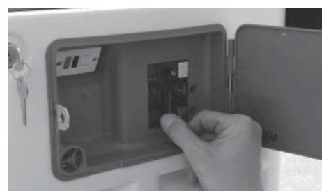
1. Apague el interruptor de circuito principal del generador y ponga el interruptor de modo en la posición OFF (apagado).
