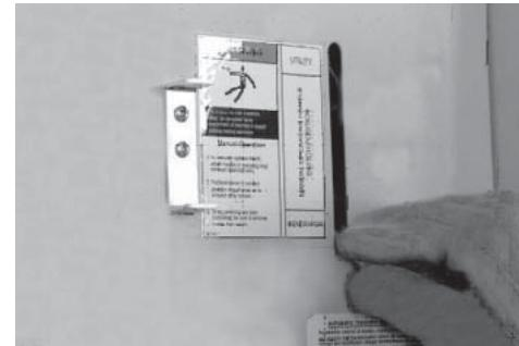
6. Localiser la poignée de transfert, insérer l'extrémité en métal dans la fente du contacteur principal. Tirer la poignée VERS LE BAS pour déplacer les principaux contacts vers la position de l'alimentation de secours (générateur).
