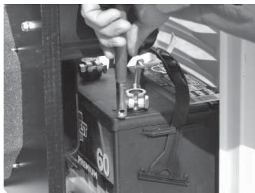
2. Suivre toutes les procédures et précautions de sécurité du Manuel d'entretien du générateur lors de l'installation de la batterie. Vérifier que l'interrupteur se trouve sur la position OFF (Arrêt). Lors de la préparation du test opérationnel, NE PAS connecter la batterie avant que les branchements du commutateur de transfert n'aient été effectués.
