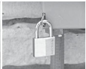
5. Pour les modèles 10-20 kW, localiser le fermoir en métal qui est emballé dans le sac du manuel d'entretien. Insérer le fermoir dans la fente située sur le côté gauche de la boîte externe du disjoncteur. S'assurer que le clip du fermoir fait face à l'avant du générateur. Si on le souhaite, verrouiller la boîte externe.
