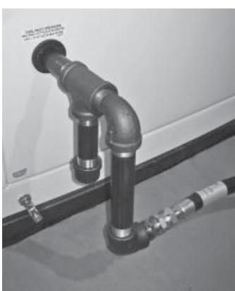
4. Lors du raccordement de la canalisation de gaz au générateur, utiliser la partie fournie du tuyau flexible de carburant certifié UL ou approuvé AGA conformément aux réglementations locales. Le tuyau flexible de carburant sert à s'assurer que les vibrations provenant
