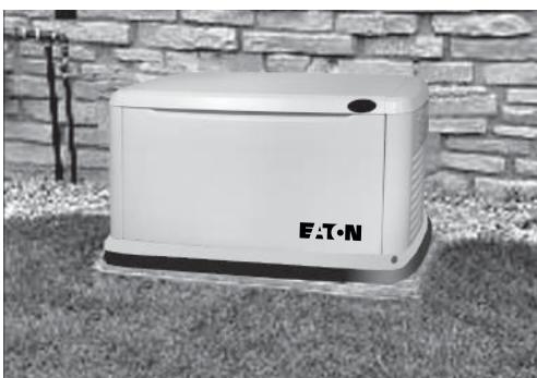
5. Coloque el generador en la almohadilla para que la cama de gravilla se extienda algunas pulgadas más allá del generador en todos los lados. Asegúrese de que el generador esté nivelado dentro de la 1/2 pulgada.
