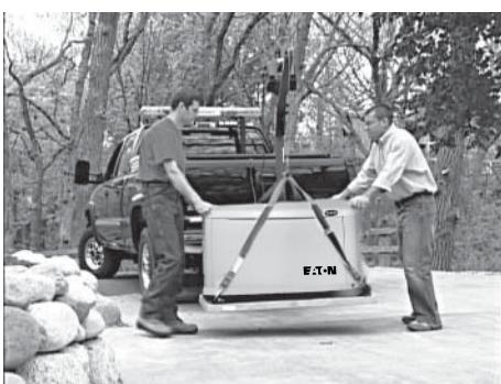
4. S'assurer que l'équipement de levage utilisé a une capacité suffisante pour gérer de manière sécurisée le poids du générateur. Utiliser les ères de levage en nylon et les raccorder aux œillets de levage sur chaque coin du bâti de base afin d'éviter d'endommager l'enveloppe.
