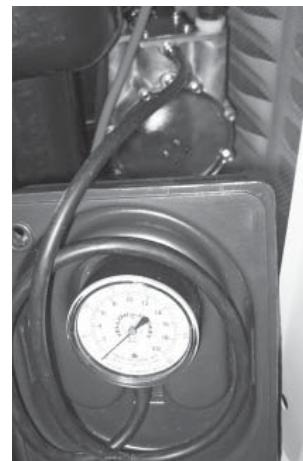
3. Afin d'entrer la canalisation de gaz dans le générateur, installer un raccord en T afin de pouvoir surveiller la pression de gaz. Sur l'une des ouvertures du raccord, installer un mamelon NPT de 0,25 po. et un bouchon fileté. Dans certains cas, il est également possible d'installer un bassin de décantation.
