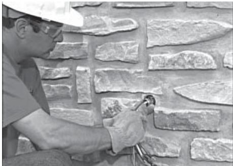
1. Percer un trou de 1,75 pouce et alimenter le conduit à travers le trou.
