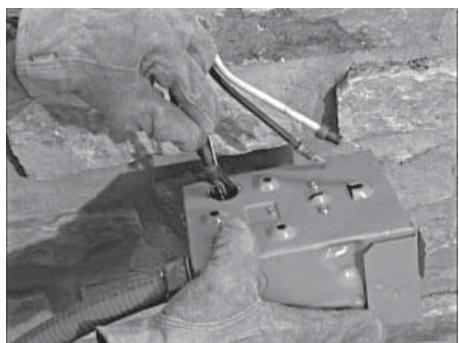
2. Retirer la débouchure de l'arrière de la boîte de jonction (le cas échéant), alimenter les fils à travers l'arrière de la boîte et fixer le conduit à l'aide d'un contre-écrou. Sceller le trou avec de la pâte de silicone. Ne pas oublier de calfeutrer le trou à l'intérieur de la boîte également.
