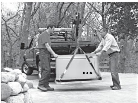
4. Asegúrese de que el equipo de elevación a usarse tenga la suficiente capacidad para manejar en forma segura el peso del generador. Use cuerdas de elevación de nylon y conéctelas a los ojales de elevación en cada esquina del marco de la base para evitar daños en la caja.
