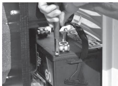
1. El generador fue configurado para operación con gas natural en la fábrica. El cambio a GLP es un procedimiento simple. En los modelos con un motor de cilindro único, empiece desconectando y retirando la batería si está instalada.
