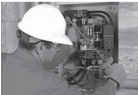
5. Teniendo cuidado de sostener las lengüetas, aplique torque a las lengüetas en el interruptor de transferencia a las especificaciones en el interruptor de transferencia. Calcomanía ubicada dentro de la puerta del interruptor.
