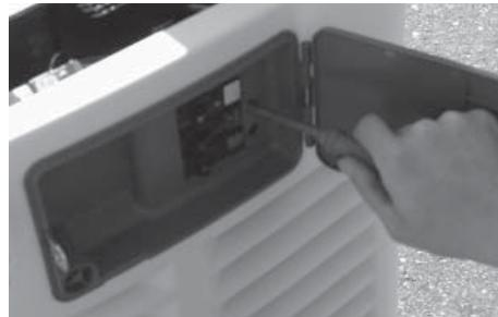
7. Retirer les fiches en plastique à l'intérieur de la zone d'accès du disjoncteur principal pour permettre le branchement des fils d'alimentation au disjoncteur.
