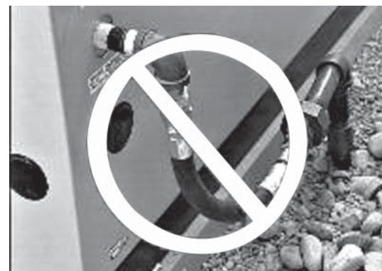
5. Nunca doble la línea flexible de combustible para evitar usar un codo. El doblar una línea flexible disminuye su capacidad de absorber vibraciones y frustra su propósito así como constriñe su flujo real de combustible.
