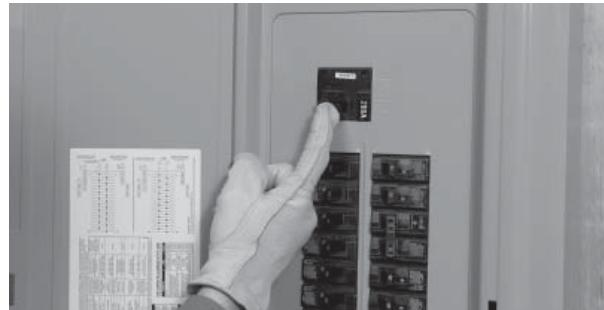
14. Encienda el interruptor principal para restaurar la energía pública. El generador continuará funcionando para permitir que el motor se enfrie antes de apagarse solo. Apague la energía pública nuevamente. El generador deberá arrancar y la carga de prioridad entera deberá transferirse al generador. Cierre el interruptor principal para restaurar la energía pública y deje que el motor enfrie y se apague.
