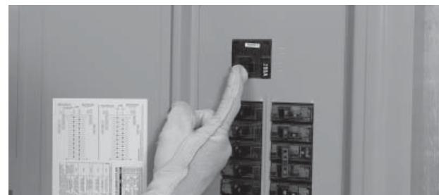
11. Si tout fonctionne correctement, placer le disjoncteur principal sur la position ON (Marche) et s'assurer que l'alimentation est automatiquement transférée vers le réseau public.
