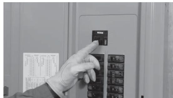
13. Apague la energía pública y asegúrese de que el generador arranca automáticamente luego del retardo del interruptor de línea.
