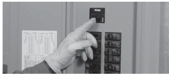
15. Apague la energía pública nuevamente para arrancar automáticamente el generador. Cuando la energía se haya transferido al generador, cierre cada uno de los interruptores en el panel de distribución uno a la vez hasta que el generador haya aceptado la carga entera.
