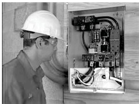
3. La tierra que está normalmente en el panel principal debe conseguirse en el interruptor nominal de servicio y debe estar desconectada en el panel de distribución existente. Consulte el Código Eléctrico Nacional (NEC) para una información completa sobre conexión a tierra y ajustes.
