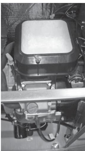
3. Afin d'entrer la canalisation de gaz dans le générateur, installer un raccord en T afin de pouvoir surveiller la pression de gaz. Sur l'une des ouvertures du raccord, installer un mamelon NPT de 0,25 po. et un bouchon fileté. Dans certains cas, il est également possible d'installer un bassin de décantation.
