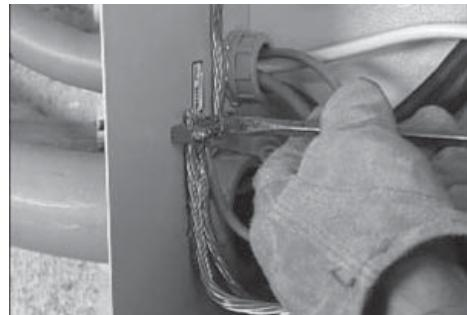
4. Complete el cableado al interruptor de transferencia conectando los cables de tierra del equipo del servicio público y el generador a la lengüeta de tierra.
