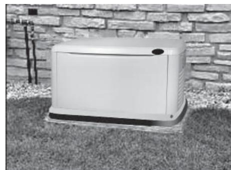
5. Placer le générateur sur le massif de manière à ce que le lit de gravier s'étende de plusieurs pouces au-delà du générateur de tous les côtés. S'assurer que le générateur est à niveau à plus ou moins 0,5 pouce.
