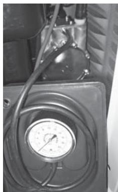
16. Con el generador llevando la carga entera, revise la presión del gas para verificar que está al mismo nivel que estaba antes de que arranque el generador.
