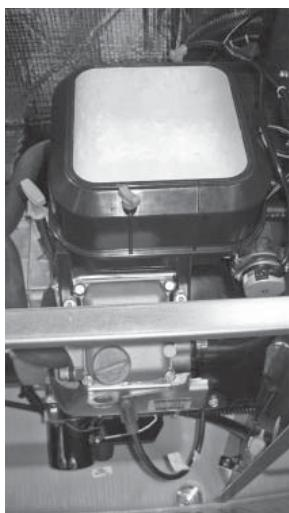
3. En el lugar en que la línea de gas ingresa al generador, instale un accesorio en T para el monitoreo de la presión de gas. En una abertura del accesorio instale un chupón NPT de  $\frac{1}{4}$ " y una tapa roscada. En algunos casos se puede instalar una trampa de sedimentos.
