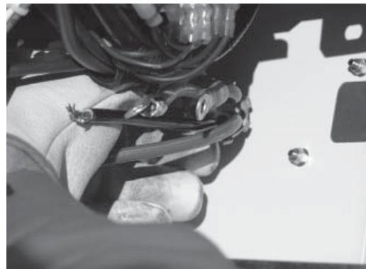
4. Alimenter les fils à travers l'arrière du générateur et fixer le conduit à l'aide du contre-écrou.
