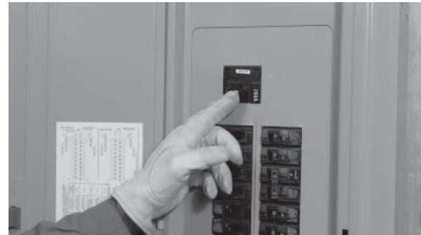
2. Placer le disjoncteur principal sur la position OFF (Arrêt). Se reporter à la norme NFPA 70-E pour connaître l'équipement de sécurité nécessaire lors d'un travail à l'intérieur d'un commutateur de transfert.
