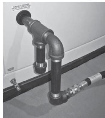
4. Al conectar la línea de gas al generador, use la sección proporcionada de línea de combustible flexible aprobada por la AGA y listada en la UL de acuerdo con las regulaciones locales. El propósito de la línea flexible de combustible es asegurar que la vibración del generador no cause una fuga de gas en uno de los puntos de conexión, de modo que es importante que la línea se instale con la menor cantidad posible de dobleces.
