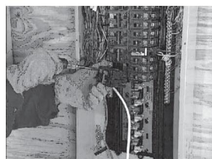
11. Installer un disjoncteur bipolaire sur le panneau de distribution pour protéger le commutateur de transfert. L'intensité nominale requise
