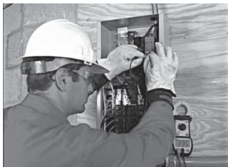
5. S'assurer que la tension et la fréquence du générateur sont correctes. Si la tension phase à phase n'est pas d'environ 240 volts, se reporter au Manuel d'entretien pour consulter les procédures de réglage appropriées. Sur tous les modèles, si la tension phase à phase n'est pas de 120 volts, vérifier le branchement du fil neutre entre le générateur et le commutateur de transfert.
