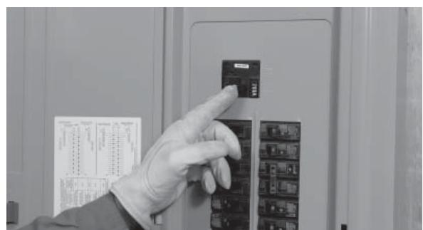
5. Asegúrese que la energía pública esté apagada y coloque todos los interruptores de circuito individual en el panel principal de distribución en la posición OFF (apagado).
