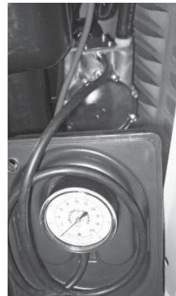
6. Après la détection des fuites, vérifier la pression de gaz au niveau du régulateur afin de s'assurer qu'il ya une pression assez de gaz pour le fonctionnement du générateur. Voir le manuel du propriétaire pour connaître les spécifications de pression de carburant. Si ce n'est pas dans ces limites, contactez votre fournisseur de gaz local.
