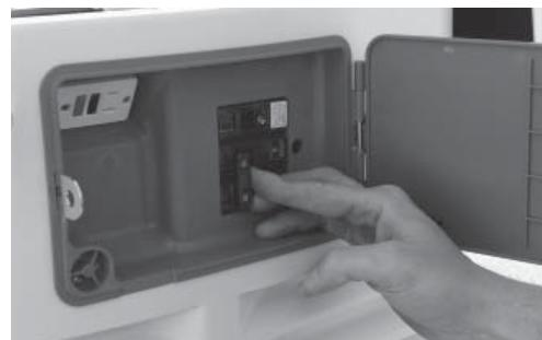
12. Conmute el interruptor principal del generador a la posición ON y coloque el interruptor de modo en AUTO.
