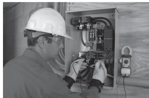
8. S'assurer que la tension et la fréquence du générateur sont correctes. Si la tension phase à phase n'est pas d'environ 240 volts, se reporter au Manuel d'entretien du générateur pour consulter les procédures de réglage appropriées. Si la tension phase à phase n'est pas d'environ 120 volts, vérifier le branchement du fil neutre entre le générateur et le commutateur de transfert.
