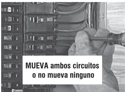
5. Cuando se usa cable de tres conductores, dos circuitos de 120 voltios frecuentemente compartirán el mismo cable neutral. Para evitar sobrecargar el neutral, mueva AMBOS circuitos que comparten el neutral o no mueva ninguno de ellos.
