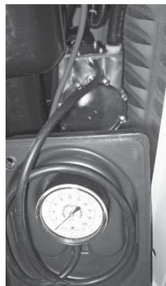
13. Con el generador llevando la carga de prioridad entera, revise la presión del gas para verificar que está al mismo nivel que estaba antes de que arrancó el generador.
