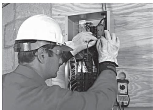
3. Energice el servicio público y revise el voltaje línea a línea a neutro en los terminales N1 y N2 del contactor de transferencia. Si el voltaje de línea a línea no es aproximadamente de 240 voltios, desenergice la energía pública y revise las terminaciones entre el servicio público y N1 y N2.
