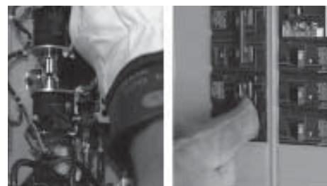
8. Use el manubrio de transferencia para mover los contactos principales en el interruptor de transferencia a la posición ARRIBA (servicio público). Commute el interruptor de 2 polos a ON en el panel de distribución.
