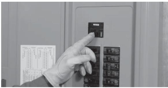
13. Mettre le réseau public hors tension et s'assurer que le générateur démarre automatiquement après le délai d'interruption de ligne.
