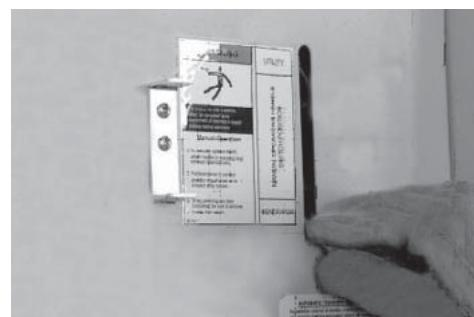
6. Ubique el manubrio de transferencia, inserte el extremo de metal en la ranura en la unidad de contactor principal. Tire el manubrio ABAJO para mover los contactos principales a la posición de energía de respaldo (generador).
