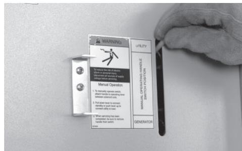
9. При **ВЫКЛЮЧЕННОМ** питании системы энергоснабжения, используя рычаг перевода, сдвиньте главные контакты в **ВЕРХНЮЮ** позицию (энергоснабжение).
