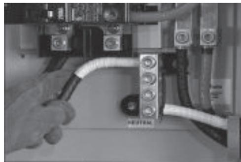
2. Нейтральные провода системы энергоснабжения и генератора подключены к тем же электромонтажным петлям нейтрали на переключателе.
