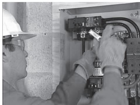
1. Подключите питающие провода как от генератора, так и от системы энергоснабжения к соответствующим электромонтажным петлям на вводе резерва. Петли четко обозначены на данном переключателе.
