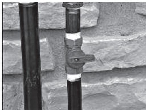
7. По окончании проверки давления газа закройте ручной отсечной клапан.
