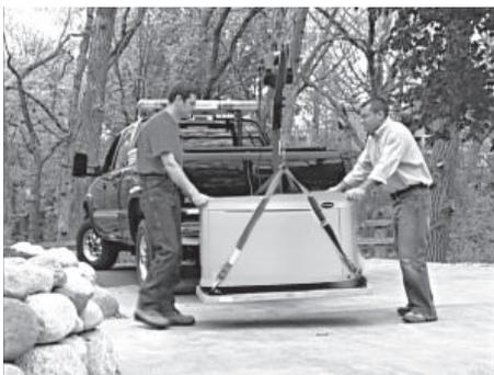
4. Обеспечьте использование подъемного оборудования с достаточной грузоподъемностью для безопасного перемещения генератора.
