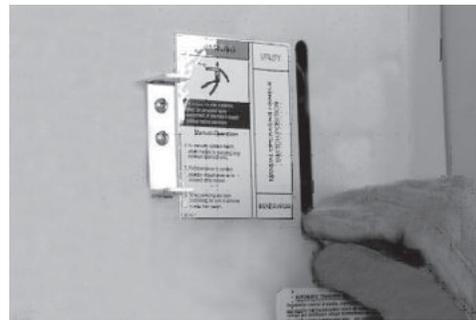
5. Ubique la manija de transferencia e inserte el extremo en la ranura del conjunto del contactor principal. Tire de la manija hacia ABAJO para mover los contactos principales a la posición de alimentación de respaldo (generador). **NUNCA OPERE EL INTERRUPTOR DE TRANSFERENCIA MANUALMENTE CUANDO HAYA CARGAS CONECTADAS.**
