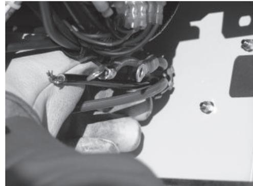
2. Pase los cables a través de la parte trasera del generador y sujete el conducto.
