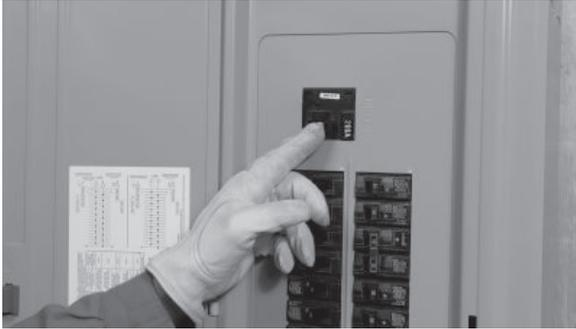
1. Ajuste en OFF el disyuntor principal del servicio público. Consulte la norma NFPA 70-E para el equipo de seguridad requerido cuando se trabaja dentro de un sistema vivo.
