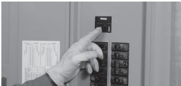
14. Повторно ВЫКЛЮЧИТЕ питание системы энергоснабжения, чтобы автоматически запустить генератор. Когда питание передается на генератор, одновременно замкните каждый из размыкателей на распределительной панели, пока генератор не получил полную нагрузку.
