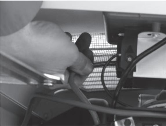
6. Ahora conecte los conductos de alimentación al disyuntor. Dado que se trata de una aplicación monofásica, no importa qué conductor de alimentación se conecte a cada terminal.
