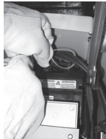
3. Pase los conductores de alimentación a través de un amarre para cables o algún otro tipo de alivio de tensión.
