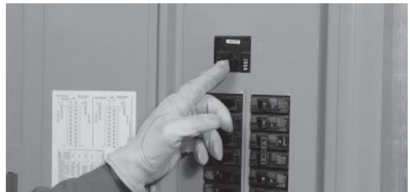
14. Apague nuevamente la fuente de alimentación del servicio público para poner en marcha el generador automáticamente. Cuando se haya transferido la alimentación al generador, cierre cada uno de los disyuntores del tablero de distribución, de a uno por vez, hasta que el generador haya aceptado la carga completa.
