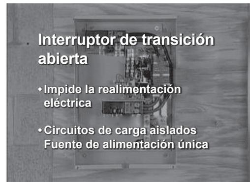
6. El interruptor de transferencia que se utiliza es un interruptor de transferencia de transición abierta. Los interruptores de transición abierta impiden la realimentación eléctrica entre el generador y el servicio público permitiendo que los circuitos de carga estén conectados a una sola fuente de alimentación por vez.
