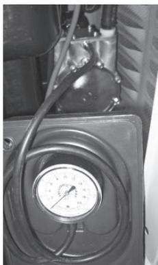
15. Как только генератор получит полную нагрузку, повторно проверьте значение давления газа, которое должно быть на том же уровне, что и при запуске агрегата. Давление не должно быть больше чем на 2,54 см (1 дюйма) водяного столба от исходного измеренного значения.
