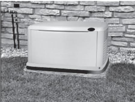
5. Coloque el generador sobre la base de manera que la cama de grava se extienda más allá del generador en todos los lados. Asegúrese de que el generador esté nivelado dentro de  $\frac{1}{2}$  pulgada.
