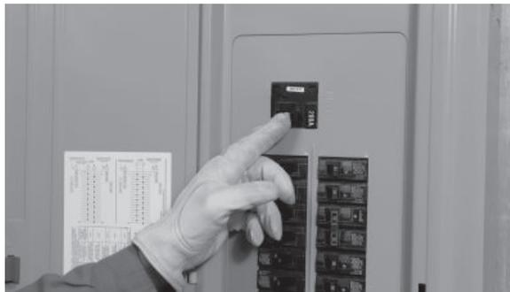
1. Переключите главный размыкатель системы энергоснабжения в положение OFF (ВЫКЛ.). Требования к безопасности пользования оборудованием при работающем вводе резерва см. в NFPA 70-E.
