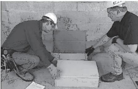
2. Всегда проверяйте переключатель ввода резерва на наличие повреждений, возникших при транспортировке. Никогда не монтируйте ввод резерва с видимыми повреждениями.
