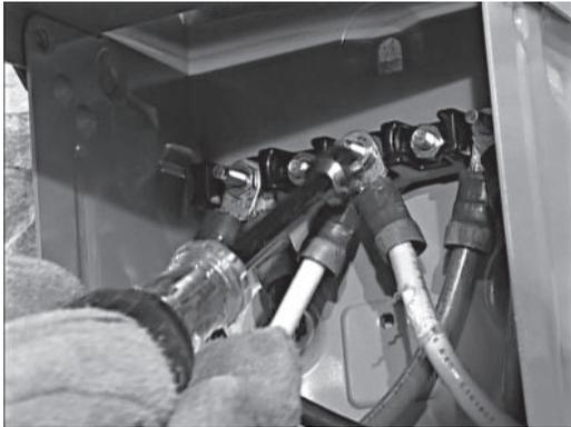
3. Monte la caja de conexiones de manera que cubra completamente el agujero de la pared. Calafatee alrededor de los costados y la parte superior de la caja para asegurarse de que el sellado sea adecuado. Conecte todos los cables a los terminales de la caja de conexiones (negro con negro, rojo con rojo y blanco con blanco). Instale el cable verde de conexión a tierra en el tornillo de conexión a tierra e instale los dos tapones pequeños con los extremos del receptáculo coincidente.
