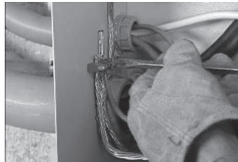
4. Complete el cableado el interruptor de transferencia conectando los cables de conexión a tierra del equipo tanto del servicio público como del generador al terminal de conexión a tierra.
