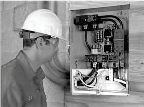
2. La conexión a tierra que se encuentra normalmente en el tablero principal se debe efectuar en el interruptor calificado para servicio y se debe desconectar del tablero de distribución existente.
