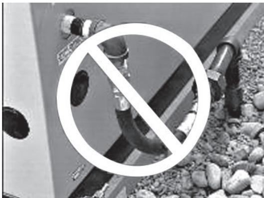
5. Никогда не гните гибкий трубопровод там, где можно использовать коленный фитинг. Изогнутость гибкого трубопровода снизит его способность поглощать вибрации, сведет на нет его назначение, а также будет препятствовать реальному прохождению топлива.
