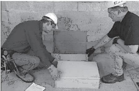
2. Siempre inspeccione el interruptor en busca de daños en el envío. No monte nunca un interruptor de transferencia que muestre alguna evidencia de daños.
