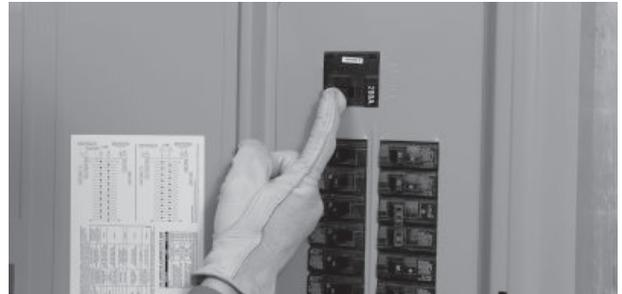
16. Переключите размыкатель системы энергоснабжения в позицию ON (ВКЛ.), чтобы вернуть данную систему в обычный режим.
