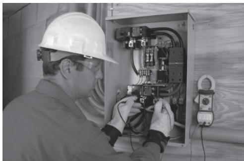
7. Проверьте напряжение и частоту генератора, чтобы убедиться в соответствии правильным значениям. Если напряжение между подключенными линиями не составляет приблизительно 220 В, надлежащие процедуры регулировки см. в руководстве пользователя генератора. Если напряжение подключенной к нейтрали линии (при наличии) не составляет приблизительно 110 В, проверьте соединение нейтрали между генератором и вводом резерва.
