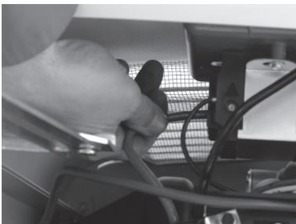
6. Далее подключите питающие провода к размыкателю цепи. Поскольку это – однофазное решение, не имеет значения, к какой именно электромонтажной петле который из питающих проводов подключается.
