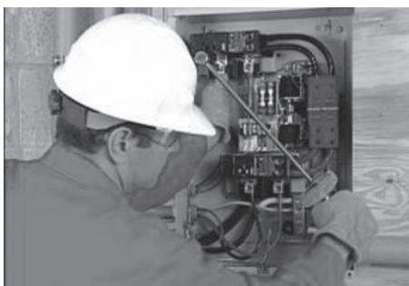
5. Осторожно поддерживая, затяните электромонтажные петли на вводе резерва так, как указано в его технических условиях. Соответствующая наклейка расположена с внутренней стороны дверцы данного переключателя.
