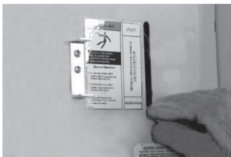
5. Найдите рычаг переключателя, вставьте металлический конец в отверстие на главном блоке замыкателя. Потяните рычаг ВНИЗ, чтобы сдвинуть главные контакты в позицию резервного питания (генератора).
