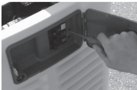
4. Размыкатель цепи подсоединяется к внешней панели доступа.
