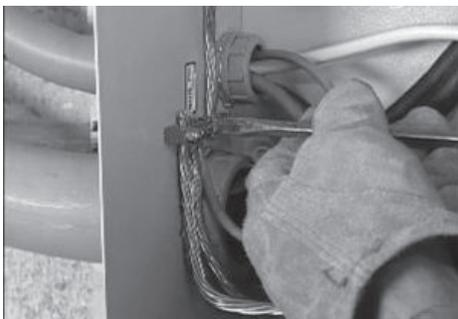
4. Завершите подключение проводки ввода резерва, присоединив заземляющие провода оборудования как от системы энергоснабжения, так и от генератора к соответствующей электромонтажной петле.
