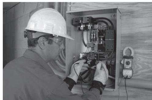
7. Compruebe para asegurarse de que el voltaje y la frecuencia del generador sean correctos. Si el voltaje entre líneas no es aproximadamente 220 V, consulte en el Manual del propietario del generador los procedimientos de ajuste apropiados. Si el voltaje entre línea y neutro (si corresponde) no es aproximadamente 110 V, compruebe la conexión de neutro entre el generador y el interruptor de transferencia.
