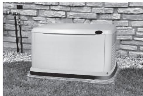
1. Для установки следует выбирать место как можно ближе к вводу резерва и топливной системе. Оставьте достаточно места вокруг агрегата для проведения обслуживания (сверьтесь с местными нормами). Разместите генератор относительно высоко, чтобы не допустить попадание в него поднимающейся воды. Выберите открытое пространство, где будет обеспечиваться достаточное и беспрепятственное обтекание потоками воздуха (см. раздел «Расположение» в руководстве пользователя).
