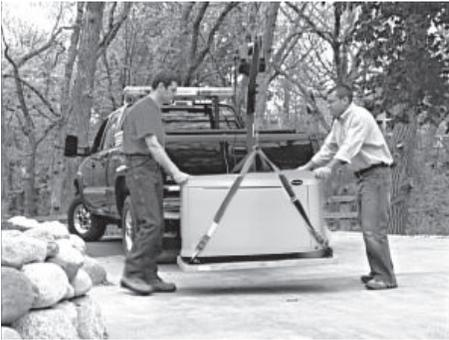
4. Asegúrese de que el equipo de izado utilizado tenga capacidad suficiente para manejar el peso del generador con seguridad. Use tiras de izado de nylon y colóquelas en las argollas de izado de cada esquina del bastidor de la base para evitar daños al gabinete.
