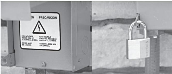
4. Vuelva a colocar la placa de cubierta protectora y el tornillo de retención y cierre la caja de conexiones.
