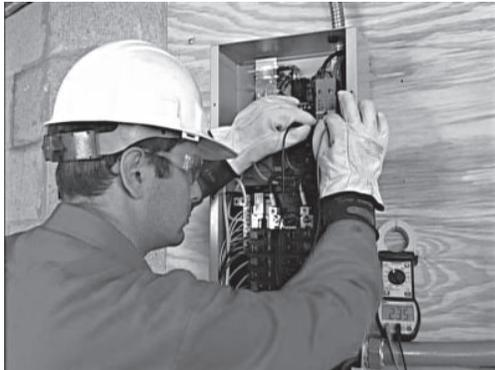
2. Conecte la fuente de alimentación del servicio público y compruebe el voltaje entre líneas y entre línea y neutro (s corresponde) en los terminales N1 y N2 del contactor de transferencia. Si el voltaje entre líneas no es aproximadamente 220 V, desconecte la fuente de alimentación del servicio público y compruebe las terminaciones entre el servicio público y N1 y N2.
