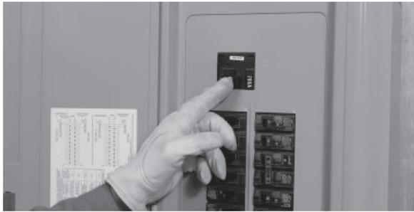
12. ВЫКЛЮЧИТЕ питание системы энергоснабжения и убедитесь, что генератор запускается автоматически после задержки прерывания линии.
