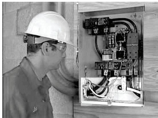
2. Заземление, которое обычно находится в главной панели, необходимо дополнить специальным переключателем для системы и отключить от существующей распределительной панели.
