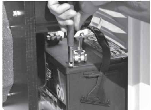
1. El generador fue configurado en la fábrica para funcionar con gas natural. Pasar a vapor de LP es un procedimiento simple. En las unidades con el motor de 8 kVA, comience desconectando y retirando la batería si está instalada. Siga todos los procedimientos y precauciones de seguridad del Manual del propietario del generador para instalar y conectar o desconectar la batería.
