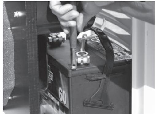
2. Siga todos los procedimientos y precauciones de seguridad del Manual del propietario al instalar la batería. Verifique que el interruptor esté en la posición OFF. Cuando se prepare para realizar las pruebas de funcionamiento, NO conecte la batería hasta que no se hayan completado las conexiones del interruptor de transferencia.
