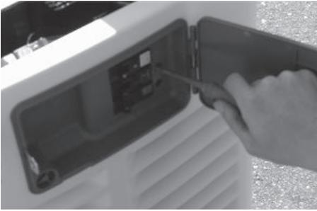
4. El disyuntor está instalado en el tablero de acceso exterior.
