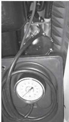
16. Con el generador soportando la carga completa, verifique de nuevo la presión del gas para comprobar que esté al mismo nivel que estaba antes de que el generador fuera arrancado.
