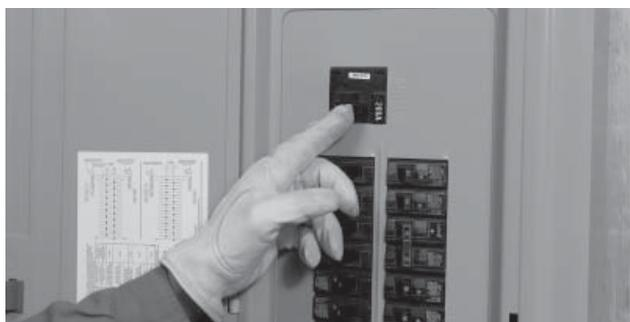
15. Remettre l'alimentation du réseau public HORS TENSION pour démarrer automatiquement la génératrice. Lorsque l'alimentation s'est transférée vers la génératrice, fermer chaque disjoncteur du panneau de distribution, un par un, jusqu'à ce que la génératrice accepte la charge complète.
