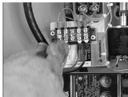
3. Conecte los cables de control del generador a las ubicaciones designadas. Los cables 0, 23 y 194 se conectan a las tiras terminales ; N1, N2, y T1 se conectan directamente a los soportes del fusible.
