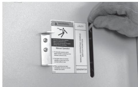
10. L'alimentation du réseau public toujours hors tension, utiliser la poignée de transfert pour déplacer les principaux contacts vers la position UP (réseau public).
