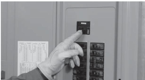
13. APAGUE la energía pública y asegúrese de que el generador arranque automáticamente después del retardo de interrupción de línea.
