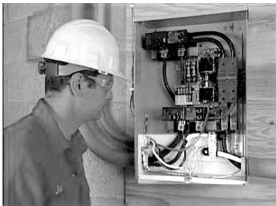
3. La mise à la terre qui est normalement située sur le panneau principal sera réalisée sur le commutateur de la même intensité que le réseau public et doit être déconnectée du panneau de distribution existant. Se reporter au National Electrical Code (NEC) pour obtenir des informations complètes sur la mise à la terre et la connexion.
