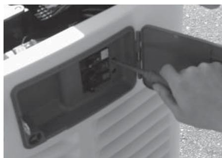
5. Retirer les fiches en plastique à l'intérieur de la zone d'accès du disjoncteur principal pour permettre le branchement des fils d'alimentation au disjoncteur.
