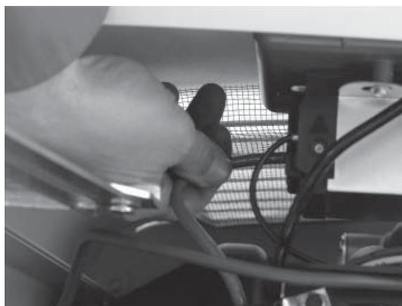
6. Brancher maintenant les fils d'alimentation rouge et noir au disjoncteur. Étant donné qu'il s'agit d'une application monophasée, cela n'a pas d'importance quel fil est branché à quelle cosse.
