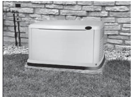
5. Coloque el generador sobre la base de manera que la cama de grava se extienda más allá del generador en todos los lados. Asegúrese de que el generador esté nivelado dentro de 1/2 pulgada.
