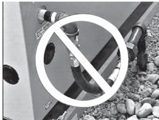
4. Nunca doble la línea de combustible flexible para evitar el uso de un codo. Doblar la línea flexible disminuye su capacidad para absorber las vibraciones y frustra su propósito así como también restringe el flujo real de combustible.
