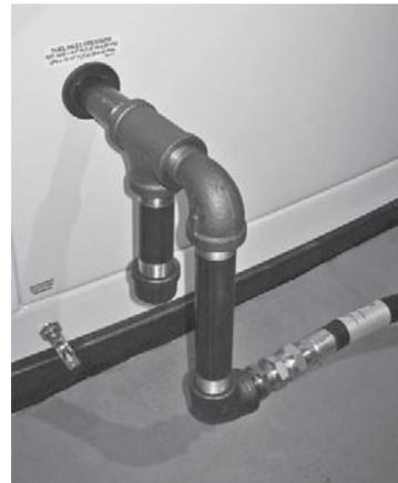
3. Cuando se conecte la línea de gas al generador, use la sección provista de línea de combustible flexible listada UL o aprobada por AGA de acuerdo con las regulaciones locales. El propósito de la línea de combustible flexible es asegurar que la vibración del generador no ocasione una fuga de gas en uno de los puntos de conexión, de modo que es importante que la línea sea instalada con unos pocos dobleces como sea posible. También se recomienda instalar una trampa de sedimentos.
