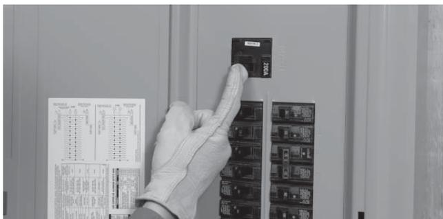
14. Placer le disjoncteur du réseau public sur la position ON (Marche) et s'assurer que l'alimentation est automatiquement transférée vers le réseau public.
