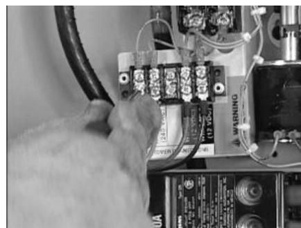
3. Brancher les fils de commande de la génératrice aux emplacements indiqués. Les fils 0, 23 et 194 se branchent à la barrette de bornes; N1, N2, et T1 se branchent directement aux portes-fusibles.
