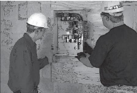
3. Protéger le commutateur contre les impacts et le monter verticalement sur une structure de support rigide. S'assurer que le commutateur est à niveau et d'aplomb. Vérifier les codes locaux avant de brancher le commutateur de transfert. Certaines juridictions exigent que le câblage situé à l'intérieur du commutateur soit réalisé par un électricien agréé.
