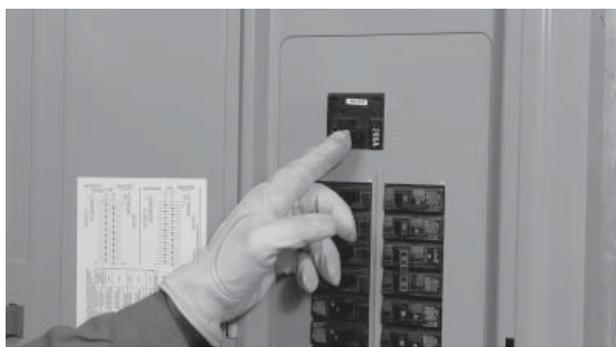
13. Mettre le réseau public HORS TENSION et s'assurer que la génératrice démarre automatiquement après le délai d'interruption de ligne.
