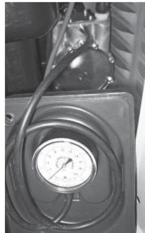
5. Après s'être assuré qu'il n'y a pas de fuite, vérifier la pression de gaz sur les ports du régulateur dedans la génératrices afin de s'assurer qu'il y a assez de pression pour le bon fonctionnement de la génératrice.
