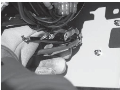
2. Alimenter les fils à travers l'arrière de la génératrice et fixer le conduit à l'aide d'un contre-écrou.
