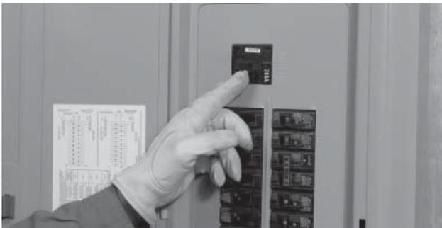
15. APAGUE la energía pública otra vez para arrancar automáticamente el generador. Cuando la energía se ha transferido al generador, cierre cada uno de los disyuntores en el panel de distribución uno a la vez hasta que el generador haya aceptado la carga completa.
