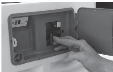
12. Placer le disjoncteur principal de la génératrice sur la position ON (Marche) et le sélecteur de mode sur la position AUTO.
