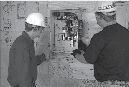
3. Proteja contra impactos y monte el interruptor verticalmente a una estructura de soporte rígida. Asegúrese de que el interruptor esté nivelado y a plomo.
