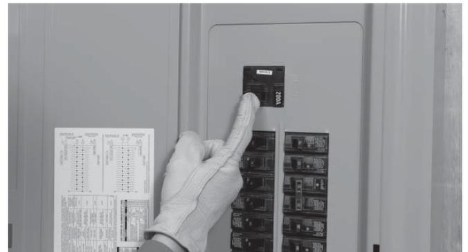
20. Cierre el disyuntor principal para restablecer la energía pública y permitir que el motor se enfríe y se apague por sí mismo. Las pruebas de funcionamiento están ahora completas. Consulte el Apéndice E— Cómo ajustar la función de ejercicio automático para completar la instalación.
