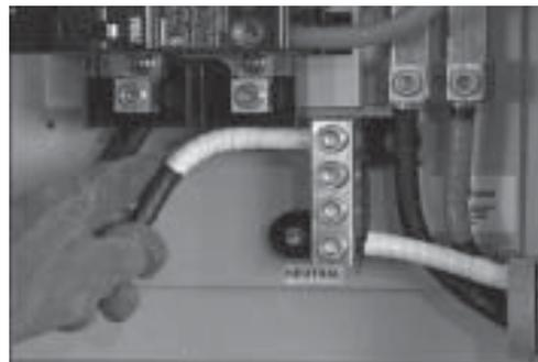
2. Los cables neutros de la red pública y el generador se conectan a la misma barra neutra en el interruptor.
