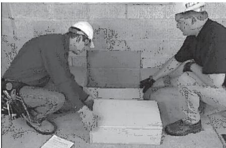
2. Inspeccione siempre el interruptor en busca de daños de envío. Nunca monte un interruptor de transferencia que muestre alguna evidencia de daños.
