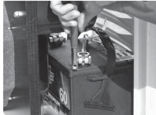
2. Siga todos los procedimientos y precauciones de seguridad detalladas en el Manual del Propietario cuando instale la batería. Verifique que el interruptor esté en la posición off. Cuando se esté preparando para prueba de funcionamiento, NO conecte la batería hasta que las conexiones del interruptor de transferencia estén completas.
