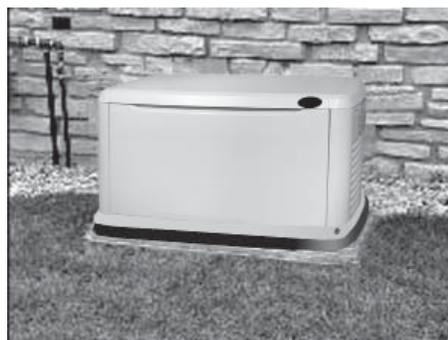
5. Installer le générateur sur le coussin protecteur afin que le lit de gravier s'étende au-delà du générateur, et ce, de chaque côté. S'assurer que le générateur est de niveau à 1/2 po.
