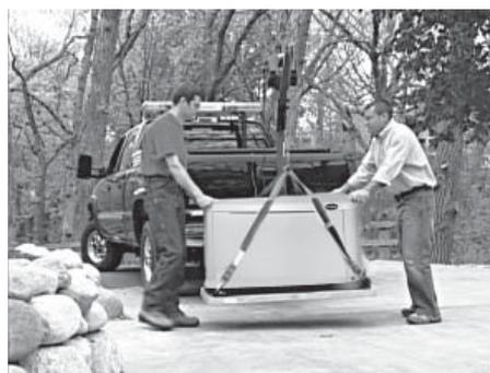
4. S'assurer que l'équipement de levage utilisé a une capacité suffisante pour gérer de manière sécurisée le poids de la génératrice. Utiliser les ertes de levage en nylon et les raccorder aux œillets de levage sur chaque coin du bâti de base afin d'éviter d'endommager l'enveloppe.
