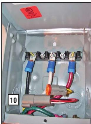
10. Levante la cubierta. Retire el tornillo de la placa de cubierta interna y la cubierta interna. Retire el dispositivo de eliminación en la esquina inferior derecha de la caja de conexiones externa. Desde la parte de atrás de la caja de conexiones, alimente cables, conectores de 4 y 2 pines en la caja. Deslice la tuerca de cierre sobre los cables y conectores y ajuste en forma segura sobre el acoplamiento del conducto. Usando las correas apropiadas, monte la caja de conexiones externa sobre
