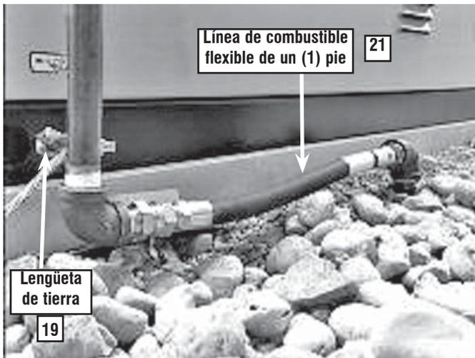
**21b.** Si se percibe una fuga, cierre el combustible y desconecte la tubería flexible. Seque los extremos roscados y vuelva a aplicar una cantidad adecuada de sellador de tubería. Reconecte la línea de combustible flexible, abra el suministro de combustible y revise las fugas. Si todavía hay fugas, repita el paso 21b.
