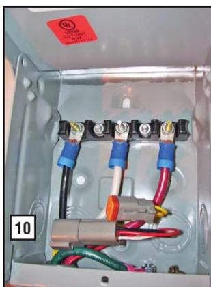
10. Soulever le couvercle. Enlever la vis de la plaque du couvercle interne et le couvercle. Retirer la débouchure du coin inférieur droit de la boîte de connexion externe. À partir de l'arrière de la boîte de connexion, passer les fils et les prises à 4 et 2 goupilles dans la boîte. Glisser l'écrou de blocage sur les fils et les prises et serrer fermement sur le raccord du conduit. En utilisant les attaches appropriées, monter la boîte de connexion externe sur un trou pré-
