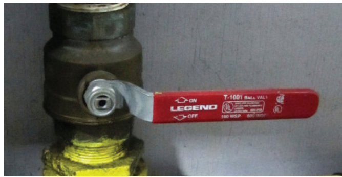
Figura 5.2 - Válvula de cierre de paso total manual
