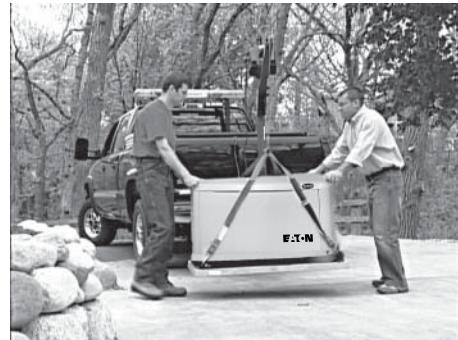
4. S'assurer que l'équipement de levage utilisé a une capacité suffisante pour gérer de manière sécurisée le poids du générateur. Utiliser les ères de levage en nylon et les raccorder aux œillets de levage sur chaque coin du bâti de base afin d'éviter d'endommager l'enveloppe.
