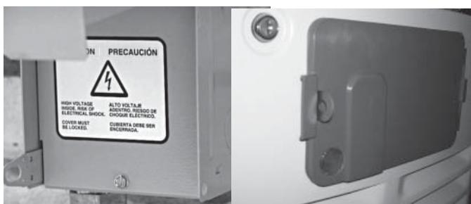
4. Vuelva a colocar la placa cubierta protectora y tornillo de retención, y cierre la caja de conexiones.
