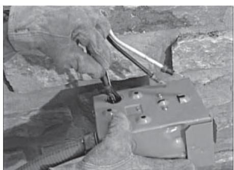
2. Retire la tapa rebatible detrás de la caja de conexiones (si se usa), alimente los cables a través de la parte de atrás de la caja y asegure al conducto con la tuerca de cierre. Selle el agujero con masilla de silicona. No olvide enmasillar el agujero dentro de la caja también.
