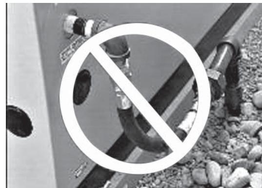
4. Nunca doble la línea flexible de combustible para evitar usar un codo. El doblar una línea flexible disminuye su capacidad de absorber vibraciones y frustra su propósito así como constriñe su flujo real de combustible.
