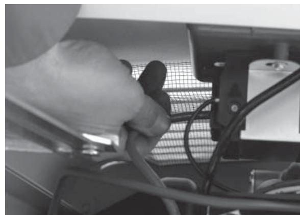
8. Brancher maintenant les fils d'alimentation rouge et noir au disjoncteur. Étant donné qu'il s'agit d'une application monophasée, cela n'a pas d'importance quel fil est branché à quelle cosse.
