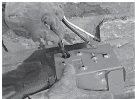
2. Retirer la débouchure de l'arrière de la boîte de jonction (le cas échéant), alimenter les fils à travers l'arrière de la boîte et fixer le conduit à l'aide d'un contre-écrou.
