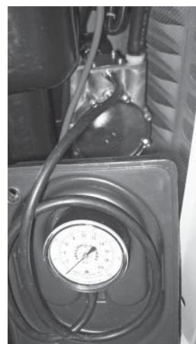
5. Despues de comprobar que no haya fugas, revise la presión del gas en el regulador para asegurarse de que no hay presión de gas suficiente para la operación del generador. Consulte el manual del propietario para conocer las especificaciones de presión de combustible. Si no es dentro de estos límites, en contacto con su proveedor de gas local.
