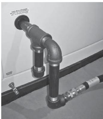
3. Al conectar la línea de gas al generador, use la sección proporcionada de línea de combustible flexible aprobada por la AGA y listada en la UL de acuerdo con las regulaciones locales. El propósito de la línea flexible de combustible es asegurar que la vibración del generador no cause una fuga de gas en uno de los
