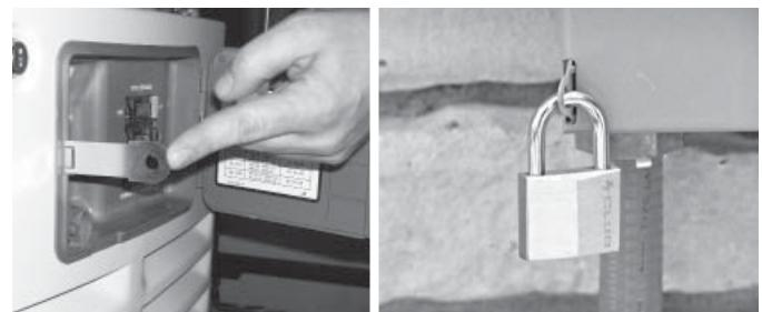
5. Localiser le fermoir en métal qui est emballé dans le sac du manuel d'entretien. Insérer le fermoir dans la fente située sur le côté gauche de la boîte externe du disjoncteur. S'assurer que le clip du fermoir fait face à l'avant du générateur. Si on le souhaite, verrouiller la boîte externe.
