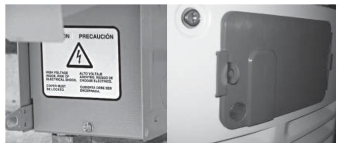
4. Remplacer le couvre-joint de protection et la vis de fixation, et verrouiller la boîte de jonction.
