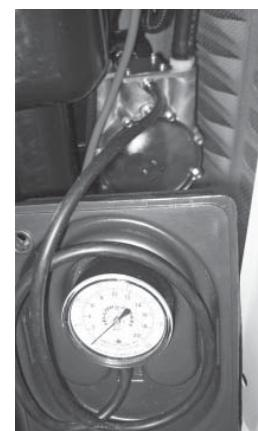
5. Après la détection des fuites, vérifier la pression de gaz au niveau du régulateur afin de s'assurer qu'il ya une pression assez de gaz pour le fonctionnement du générateur. Voir le manuel du propriétaire pour connaître les spécifications de pression de carburant. Si ce n'est pas dans ces limites, contactez votre fournisseur de gaz local.
