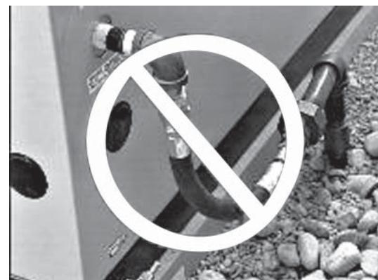
4. Ne jamais plier le tuyau flexible de carburant afin d'éviter d'utiliser un coude. Le fait de plier le tuyau flexible réduit sa capacité à absorber les vibrations, contrarie son objectif et comprime le débit actuel.
