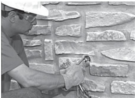
1. Percer le trou de taille appropriée et nourrir le conduit à travers le trou.
