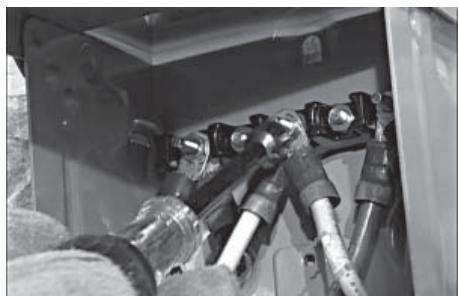
3. Monte la caja de conexiones (si se usa) de modo que cubra completamente el agujero en la pared. Masille alrededor de los lados y encima de la caja para asegurar un buen sellado. Conecte todos los cables a las orejas en la caja de conexión (negro con negro, rojo con rojo y blanco con blanco). Una el cable de tierra verde al tornillo de tierra y conecte los dos pequeños conectores a sus respectivos receptáculos.
