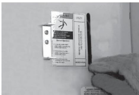
6. Ubique el manubrio de transferencia, inserte el extremo de metal dentro de la ranura en el montaje del contactor principal. Hale el manubrio hacia ABAJO para mover los contactos principales a la posición de energía de respaldo (generador).
