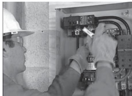
1. Conecte los cables de energía del generador y la red pública a las orejas apropiadas en el interruptor de transferencia. Las orejas están claramente marcadas en el interruptor.
