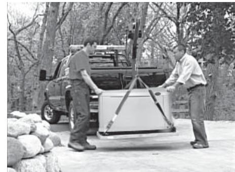
4. S'assurer que l'équipement de levage utilisé a une capacité suffisante pour gérer de manière sécurisée le poids de la génératrice. Utiliser les ères de levage en nylon et les raccorder aux œillets de levage sur chaque coin du bâti de base afin d'éviter d'endommager l'enveloppe.
