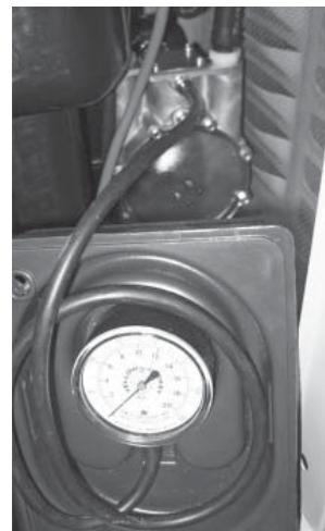
5. Despues de verificar las fugas, verifique la presión del gas en los puertos del regulador dentro del generador para asegurarse de que haya suficiente presión del gas para el funcionamiento apropiado del generador.
