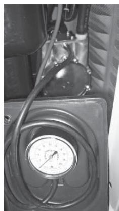
16. Con el generador soportando la carga completa, verifique de nuevo la presión del gas para comprobar que esté al mismo nivel que estaba antes de que el generador fuera arrancado.
