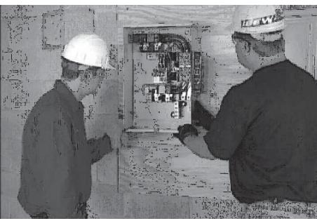
3. Proteja contra impactos y monte el interruptor verticalmente a una estructura de soporte rígida. Asegúrese de que el interruptor esté nivelado y a plomo.
