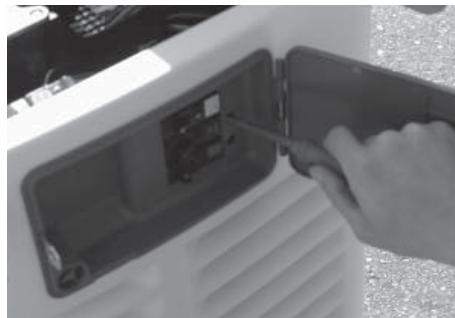
5. Retire los enchufes plásticos dentro del área de acceso del disyuntor principal para permitir la conexión de los cables de energía al disyuntor de circuito.
