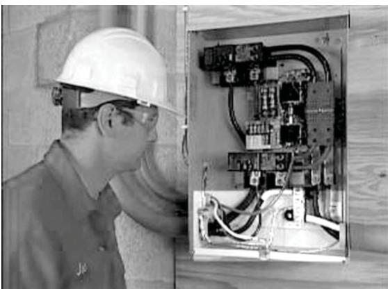
3. La puesta a tierra que está normalmente en el panel principal debe ser lograda en el interruptor clasificado de servicio y debe desconectarse en el panel de distribución existente. Consulte el Código Eléctrico Nacional (NEC) para información completa sobre la puesta a tierra y enlace.
