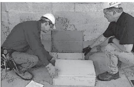
2. Inspeccione siempre el interruptor en busca de daños de envío. Nunca monte un interruptor de transferencia que muestre alguna evidencia de daños.
