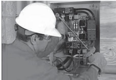
5. Siendo cuidadoso al soportar las orejas, apriete las orejas en el interruptor de transferencia a las especificaciones mostradas en el interruptor de transferencia. La calcomanía en el interior de la puerta del interruptor.
