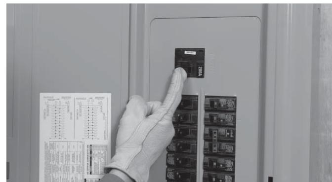
20. Fermer le disjoncteur pour rétablir l'alimentation du réseau public et laisser le moteur se refroidir et s'arrêter automatiquement. Les tests opérationnels sont désormais terminés. Se reporter à l'Annexe E - Réglage de la fonction de programme automatique.
