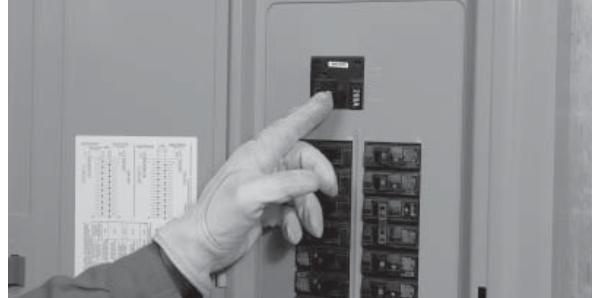
5. Asegúrese de que la energía de la red pública esté en OFF y coloque todos los disyuntores de circuitos individuales en el panel de distribución principal en la posición OFF.
