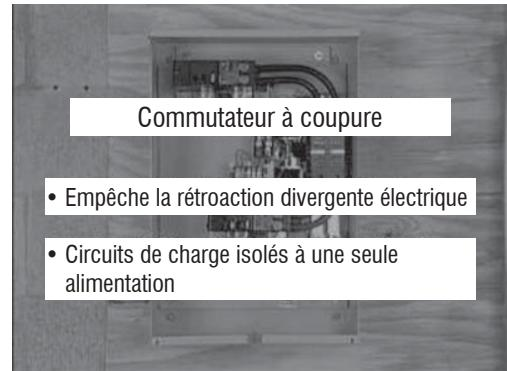
6. Le commutateur de transfert utilisé est un commutateur à coupure. Le commutateur à coupure empêche la rétroaction divergente électrique entre la génératrice et le réseau public en permettant seulement aux circuits de charge d'être connectés à une seule alimentation à la fois.
