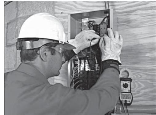
3. Energice la red pública y verifique el voltaje línea a línea y línea a neutro en las terminales N1 y N2 en el contactor de transferencia. Si el voltaje de línea a línea no es aproximadamente de 240 voltios, desenergice la energía pública y verifique las terminaciones entre la red pública y N1 y N2.
