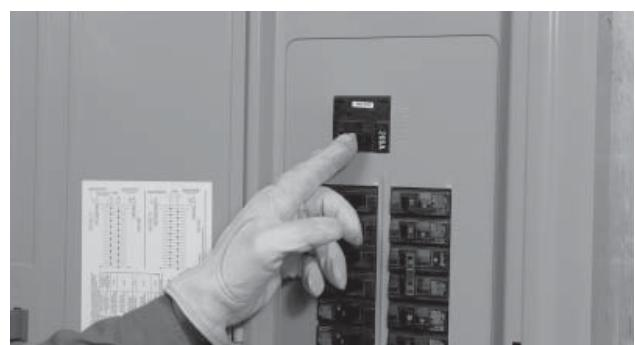
13. Mettre le réseau public HORS TENSION et s'assurer que la génératrice démarre automatiquement après le délai d'interruption de ligne.
