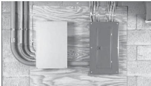
1. Antes de iniciar cualquier instalación, asegúrese de que la energía esté APAGADA al panel de distribución principal y lea cuidadosamente el Manual del Propietario que viene con el interruptor de transferencia.
