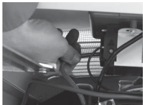
6. Brancher maintenant les fils d'alimentation rouge et noir au disjoncteur. Étant donné qu'il s'agit d'une application monophasée, cela n'a pas d'importance quel fil est branché à quelle cosse.
