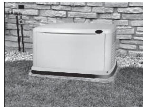
5. Coloque el generador sobre la base de manera que la cama de grava se extienda más allá del generador en todos los lados.
