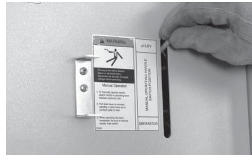
10. L'alimentation du réseau public toujours hors tension, utiliser la poignée de transfert pour déplacer les principaux contacts vers la position UP (réseau public).
