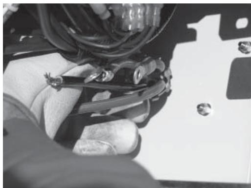
2. Inserte los cables a través de la parte trasera del generador y asegure el conducto con la tuerca de cierre.
