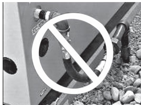
4. Nunca doble la línea de combustible flexible para evitar el uso de un codo. Doblar la línea flexible disminuye su capacidad para absorver las vibraciones y frustra su propósito así como también restringe el flujo real de combustible.
