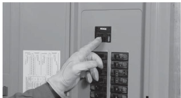
13. APAGUE la energía pública y asegúrese de que el generador arranca automáticamente después del retardo de interrupción de línea.
