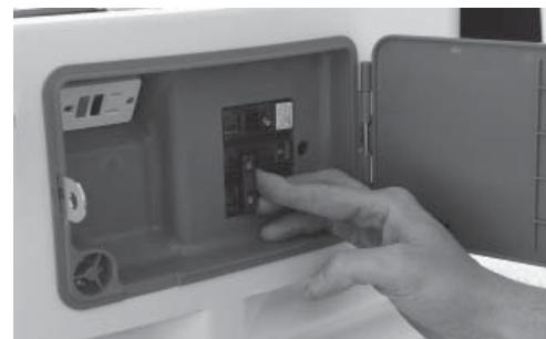
12. Placer le disjoncteur principal de la génératrice sur la position ON (Marche) et le sélecteur de mode sur la position AUTO.
