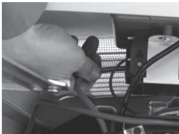
6. Ahora conecte los cables de energía rojo y negro al disyuntor de circuito. Ya que es una aplicación monofásica, no importa qué cable esté conectado a qué oreja.
