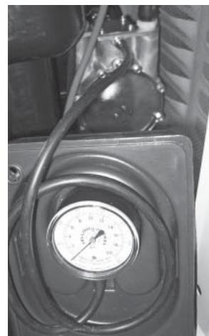
5. Après s'être assuré qu'il n'y a pas de fuite, vérifier la pression de gaz sur les ports du régulateur dedans la génératrices afin de s'assurer qu'il y a assez de pression pour le bon fonctionnement de la génératrice.
