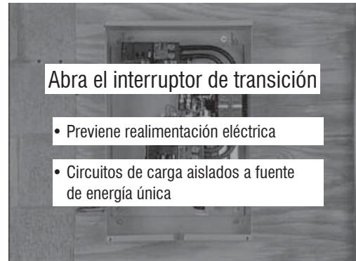
6. El interruptor de transferencia que se está usando es un interruptor de transición abierto. Los interruptores de transición abiertos previenen la realimentación eléctrica entre el generador y la red pública al permitir que sólo circuitos de carga sean conectados a una fuente de energía a la vez.
