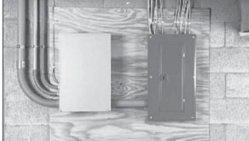
1. Avant de commencer l'installation, s'assurer que l'appareil est hors tension sur le panneau de distribution principal et lire attentivement le Manuel d'entretien fourni avec le commutateur de transfert. Pour simplifier le processus d'installation, le commutateur de transfert doit être installé aussi près que possible du panneau de distribution principal. S'assurer que ni l'eau ni des substances corrosives ne coulent sur le boîtier du commutateur de transfert.
