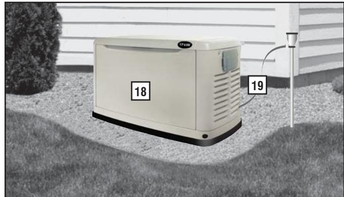
19. Fixer une extrémité de la sangle de terre (fil toronné en cuivre n°12 AWG) à la tige de terre, et l'autre extrémité à la cosse de terre (située au coin arrière de l'appareil). S'assurer que la tige de mise à la terre et la sangle ne sont pas exposées au niveau du sol (le code NEC s'applique à la méthode de mise à la terre).
