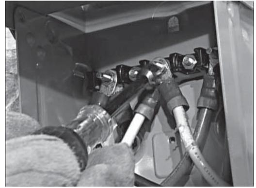
3. Monte la caja de conexión de modo que cubra por completo el agujero en la pared. Enmasille alrededor de los lados y el extremo superior de la caja para asegurar un buen sellado. Conecte todos los cables a las orejas en la caja de conexión (negro a negro, rojo a rojo y blanco a blanco). Enganche el cable de tierra verde al tornillo de tierra y conecte los dos enchufes pequeños a sus extremos de unión del receptáculo.
