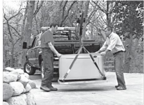
4. Asegúrese de que el equipo de levantamiento a ser usado tenga suficiente capacidad para manejar con seguridad el peso del generador. Use correas de levantamiento de nylon y conéctelas a las argollas de levantamiento en cada esquina del marco base para evitar dañar la caja.
