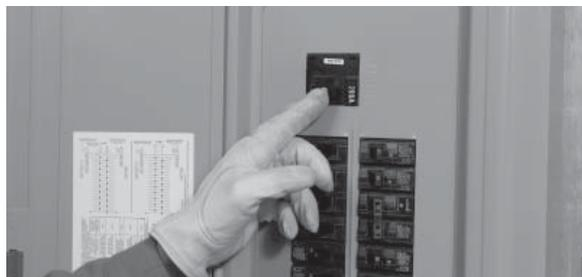
15. APAGUE la energía pública otra vez para arrancar automáticamente el generador. Cuando la energía se ha transferido al generador, cierre cada uno de los disyuntores en el panel de distribución uno a la vez hasta que el generador haya aceptado la carga completa.
