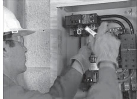
1. Brancher les fils d'alimentation du générateur et du réseau public aux cosses appropriées du commutateur de transfert. Les cosses sont clairement marquées sur le commutateur.
