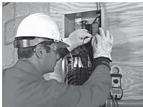
3. Mettre sous tension le réseau public et vérifier la tension phase à phase et la tension de phase nominale au niveau des bornes N1 et N2 du contacteur de transfert. Si la tension phase à phase n'est pas d'environ 240 volts, mettre hors tension l'alimentation du réseau public et vérifier les raccordements entre le réseau public et les bornes N1 et N2.
