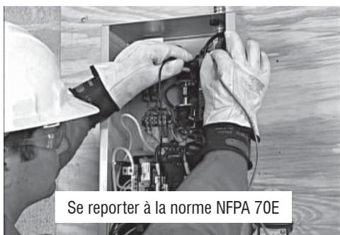
12. Lorsque tous les circuits prioritaires ont été déplacés sur le commutateur de transfert, refermer le disjoncteur principal pour rétablir l'alimentation du réseau public et s'assurer que la tension du réseau public est correcte au niveau du commutateur de transfert. Se reporter à la norme NFPA 70-E pour connaître l'équipement de sécurité nécessaire lors d'un travail à l'intérieur d'un commutateur de transfert.
