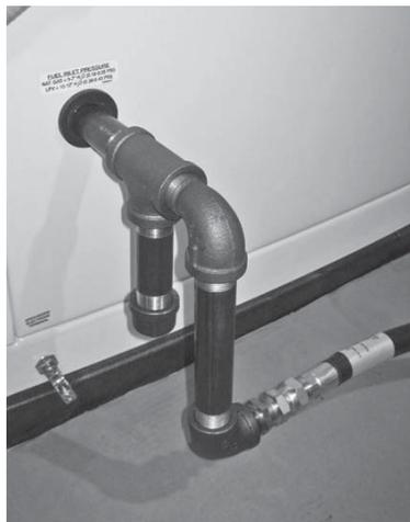
3. Cuando se conecte la línea de gas al generador, use la sección provista de línea de combustible flexible listada UL o aprobada por AGA de acuerdo con las regulaciones locales. El propósito de la línea de combustible flexible es asegurar que la vibración del generador no ocasione una fuga de gas en uno de los puntos de conexión, de modo que es importante que la línea sea instalada con unos pocos dobleces como sea posible. También se recomienda instalar una trampa de sedimentos.
