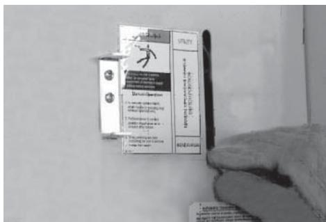
6. Localiser la poignée de transfert, insérer l'extrémité en métal dans la fente du contacteur principal. Tirer la poignée VERS LE BAS pour déplacer les principaux contacts vers la position de l'alimentation de secours (génératrice).
