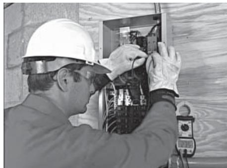
5. S'assurer que la tension et la fréquence de la génératrice sont correctes. Si la tension phase à phase n'est pas d'environ 240 volts, se reporter au Manuel d'entretien pour consulter les procédures de réglage appropriées. Sur tous les modèles, si la tension phase à phase n'est pas de 120 volts, vérifier le branchement du fil neutre entre la génératrice et le commutateur de transfert.
