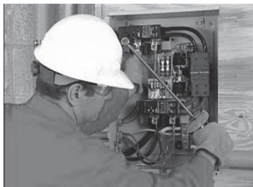
5. En veillant à soutenir les cosses, serrer les cosses du commutateur de transfert aux couples indiqués sur le commutateur de transfert. L'étiquette est située à l'intérieur de la porte du commutateur.
