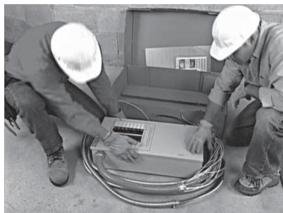
2. Inspeccione siempre el interruptor en busca de daños de envío. Nunca monte un interruptor de transferencia que muestre alguna evidencia de daños.
