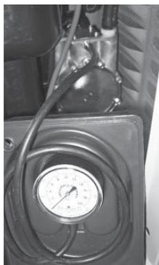
16. Con el generador soportando la carga completa, verifique de nuevo la presión del gas para comprobar que esté al mismo nivel que estaba antes de que el generador fuera arrancado.
