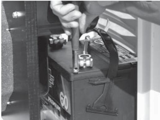
1. El generador fue configurado en la fábrica para funcionar con gas natural. Pasar a vapor de LP es un procedimiento simple. En los generadores con motor de un cilindro, comience desconectando y retirando la batería si está instalada. Siga todos los procedimientos y precauciones de seguridad del Manual del propietario al retirar y/o instalar la batería.
