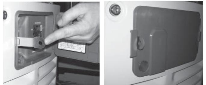
5. Para modelos de 10-20 kW, ubique el pestillo de metal que está empacado en la bolsa del manual del propietario. Inserte el pestillo en la ranura localizada en el lado izquierdo de la caja del disyuntor de circuito externo. Asegúrese de que el pasador del pestillo esté de cara hacia el frente del generador. Si se desea, cierre la caja externa.
