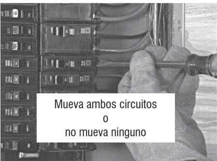
5. Cuando se usa cableado de tres conductores, dos circuitos de 120 voltios con frecuencia compartirán el mismo cable neutral. Para evitar sobrecargar el neutro, mueva **AMBOS** circuitos que comparten el neutro o no mueva ninguno de ellos.
