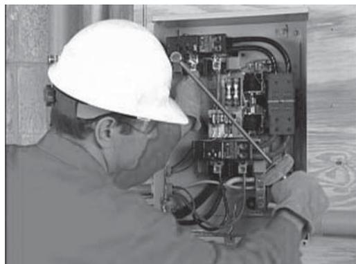
5. Siendo cuidadoso al soportar las orejas, apriete las orejas en el interruptor de transferencia a las especificaciones mostradas en el interruptor de transferencia. La calcomanía en el interior de la puerta del interruptor.
