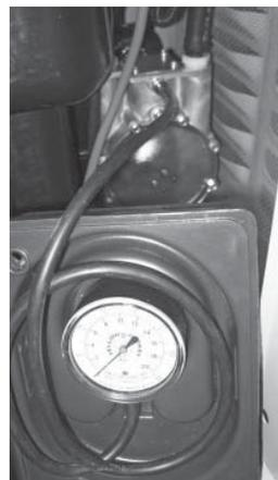
5. Después de verificar las fugas, verifique la presión del gas en el REGULADOR para asegurarse de que haya suficiente presión del gas para el funcionamiento del generador. **Consulte el manual del propietario para conocer las especificaciones de presión de combustible y clasificaciones BTU.** Si no está dentro de los límites, contacte a su proveedor de gas local.
