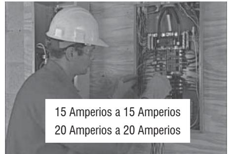
8. Usando tuercas de cable listadas UL, reconecte el cable de energía a un disyuntor correspondiente en el interruptor de circuito.
