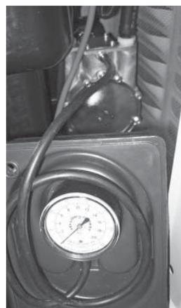
5. Après s'être assuré qu'il n'y a pas de fuite, vérifier la pression de gaz au niveau du raccord en T installé plus tôt afin de s'assurer qu'il y a assez de pression pour le bon fonctionnement de la génératrice. **Voir le manuel du propriétaire pour connaître les spécifications de pression de carburant et évaluations de Btu.** Si elle n'est pas entre ces limites, contacter le fournisseur de gaz local.
