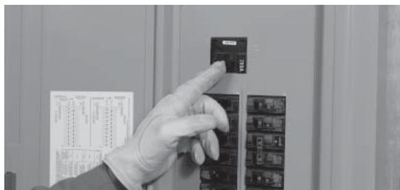
15. Remettre l'alimentation du réseau public hors tension pour démarrer automatiquement la génératrice. Lorsque l'alimentation s'est transférée vers la génératrice, fermer chaque disjoncteur du panneau de distribution, un par un, jusqu'à ce que la génératrice accepte la charge complète.
