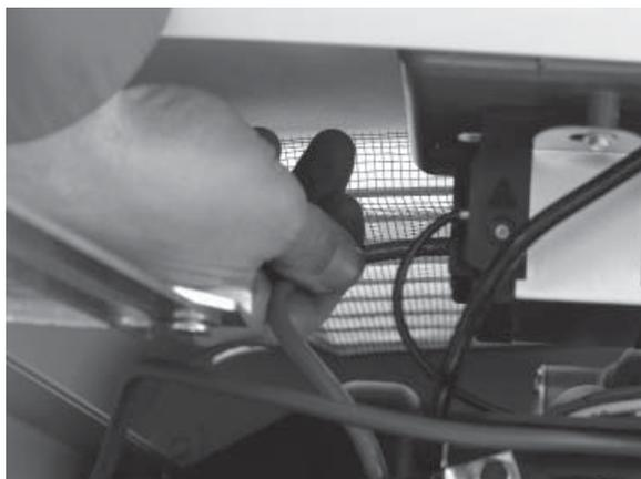
8. Ahora conecte los cables de energía rojo y negro al disyuntor de circuito. Ya que es una aplicación monofásica, no importa qué cable esté conectado a qué oreja.
