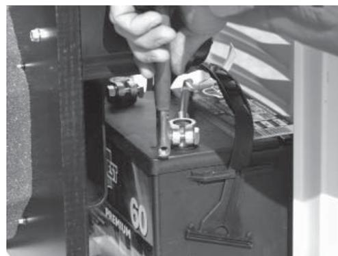
2. Suivre toutes les procédures et précautions de sécurité du Manuel d'entretien de la génératrice lors de l'installation de la batterie. Vérifier que l'interrupteur se trouve sur la position OFF (Arrêt). Lors de la préparation du test opérationnel, NE PAS connecter la batterie avant que les branchements du commutateur de transfert n'aient été effectués.
