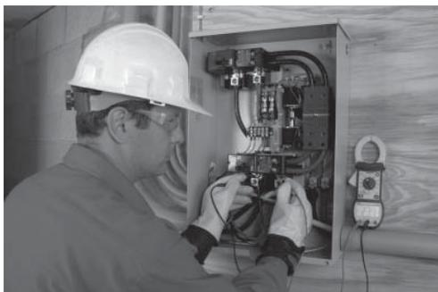
8. S'assurer que la tension et la fréquence de la génératrice sont correctes. Si la tension phase à phase n'est pas d'environ 240 volts, se reporter au Manuel d'entretien de la génératrice pour consulter les procédures de réglage appropriées. Si la tension phase à phase n'est pas d'environ 120 volts, vérifier le branchement du fil neutre entre la génératrice et le commutateur de transfert.
