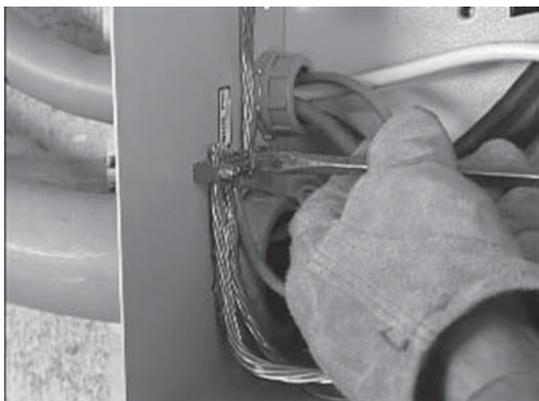
4. Terminer le câblage du commutateur de transfert en branchant les fils de mise à la terre de l'équipement du réseau public et de la génératrice à la cosse de mise à la terre.
