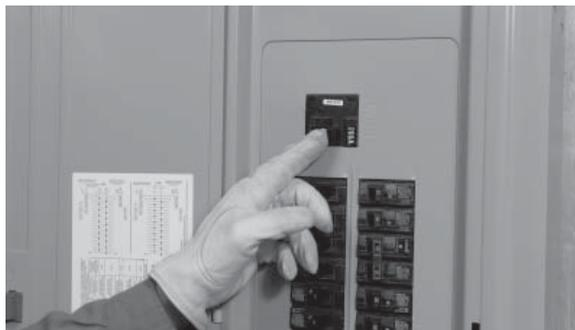
2. Gire el disyuntor de la red pública principal a la posición OFF. Consulte NFPA 70-E para el equipo de seguridad requerido cuando se trabaja dentro de un interruptor de transferencia vivo.
