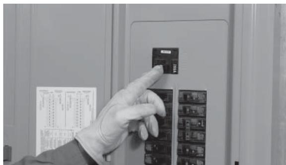
2. Placer le disjoncteur principal sur la position OFF (Arrêt). Se reporter à la norme NFPA 70-E pour connaître l'équipement de sécurité nécessaire lors d'un travail à l'intérieur d'un commutateur de transfert.
