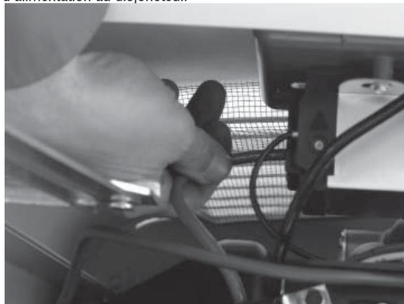
8. Brancher maintenant les fils d'alimentation rouge et noir au disjoncteur. Étant donné qu'il s'agit d'une application monophasée, cela n'a pas d'importance quel fil est branché à quelle cosse.
