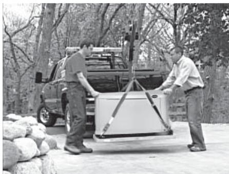
4. S'assurer que l'équipement de levage utilisé a une capacité suffisante pour gérer de manière sécurisée le poids de la génératrice. Utiliser les ertes de levage en nylon et les raccorder aux œillets de levage sur chaque coin du bâti de base afin d'éviter d'endommager l'enveloppe.
