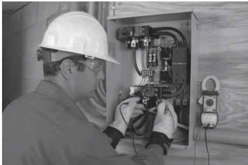
8. Asegúrese de que el voltaje y la frecuencia del generador sean los correctos. Si el voltaje de línea a línea no es aproximadamente de 240 voltios, consulte el Manual del Propietario para los procedimientos de ajuste apropiados. Si el voltaje de línea a neutro no es aproximadamente de 120 voltios, verifique la conexión del neutro entre el generador y el interruptor de transferencia.
