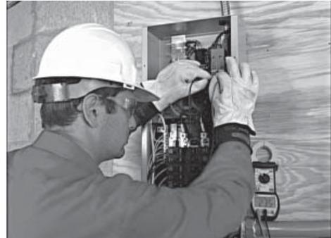
5. Asegúrese de que el voltaje y la frecuencia del generador sean los correctos. Si el voltaje de línea a línea no es aproximadamente de 240 voltios, consulte el Manual del Propietario para los procedimientos de ajuste apropiados. En todos los modelos, si el voltaje de línea a neutro no es de 120 voltios, verifique la conexión del neutro entre el generador y el interruptor de transferencia.
