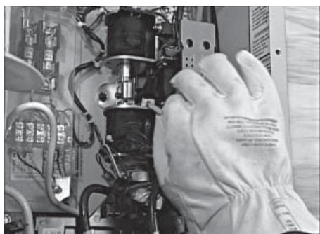
3. Localiser la poignée de transfert, insérer l'extrémité en métal dans la fente du contacteur principal et tirer la poignée VERS LE BAS pour déplacer les principaux contacts vers la position de l'alimentation de secours ou la position de la génératrice.
