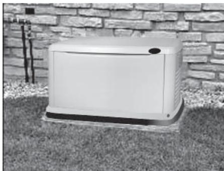
5. Installer le générateur sur le coussin protecteur afin que le lit de gravier s'étende au-delà du générateur, et ce, de chaque côté. S'assurer que le générateur est de niveau à  $\frac{1}{2}$  po.
