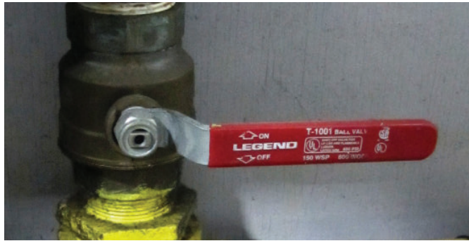
Figura 5.2 - Válvula de cierre de paso total manual
