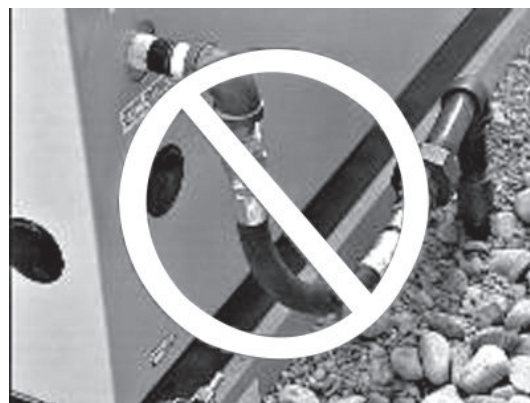
Figura 5.4 - Tendido incorrecto de la manguera flexible
