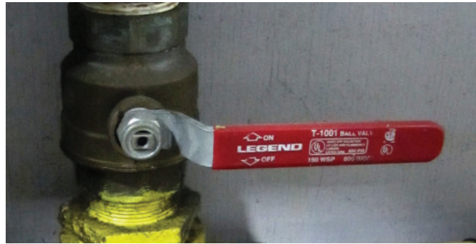
Figura 5.2 - Válvula de cierre de paso total manual
