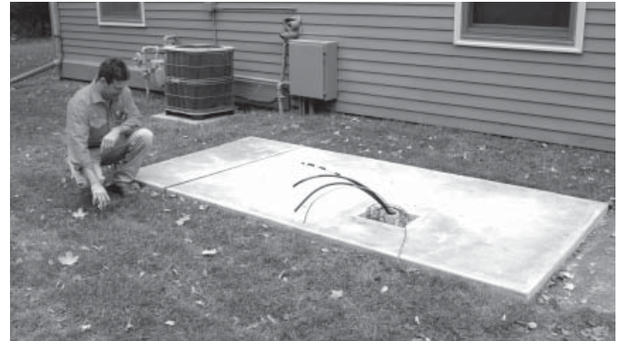
Figure 1.2 — Position Conduit
