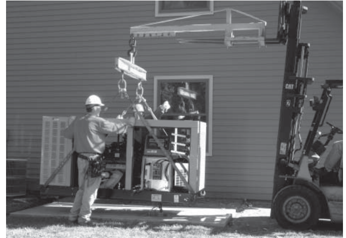
Figura 1.4 - Izado del generador
