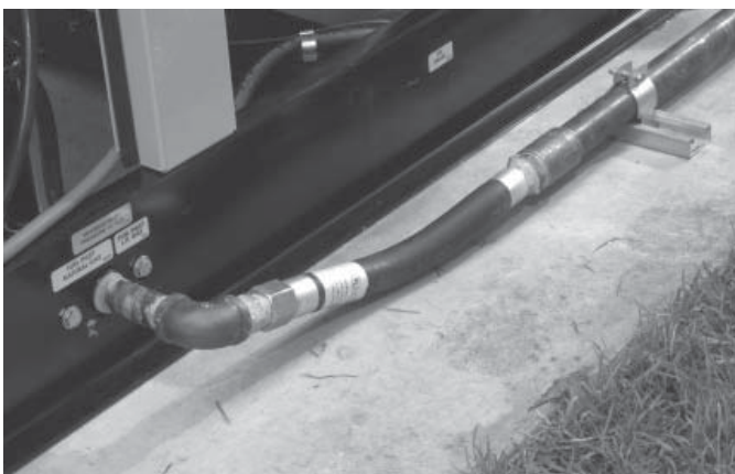
Figura 1.8 - Tubería de combustible flexible
