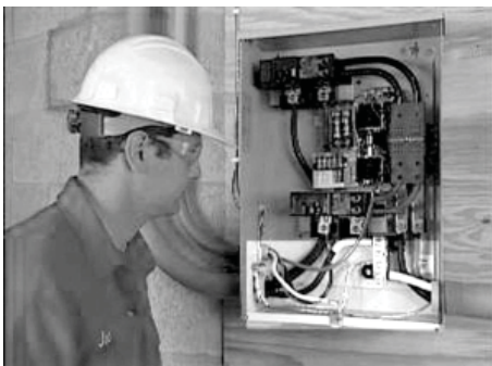
Рисунок 2.1. Подключение силовых проводов
