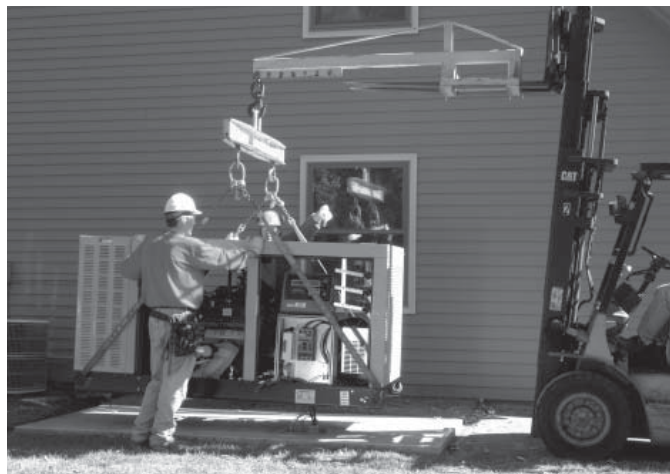
Figura 1.4 — Elevação do gerador
