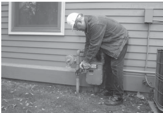
Рисунок 1.7. Запорный клапан с ручным управлением
