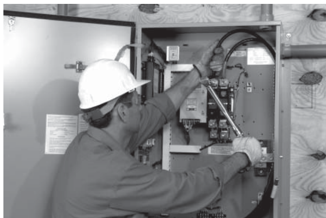
Рисунок 3.5. Затягивание клемм
