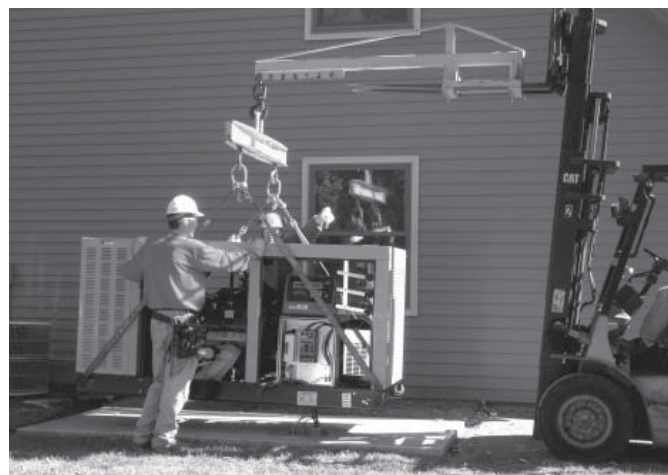
Рисунок 1.4. Подъем генератора
