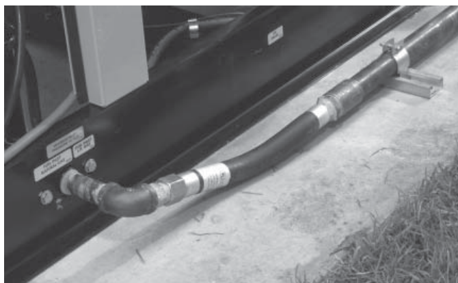
Figura 1.8 — Linha de combustível flexível
