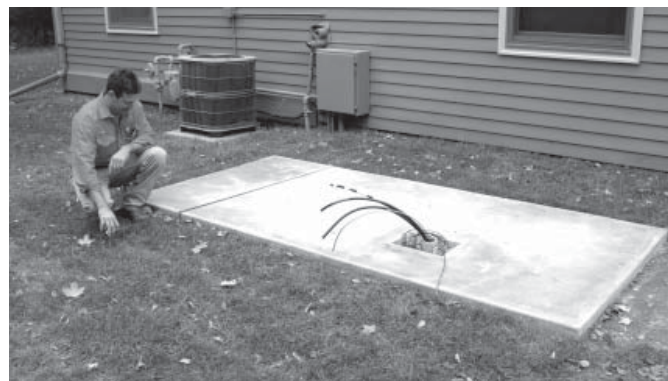
Рисунок 1.2. Расположение кабелепровода
