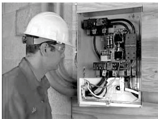
Figure 2.1 — Conexão dos cabos de alimentação
