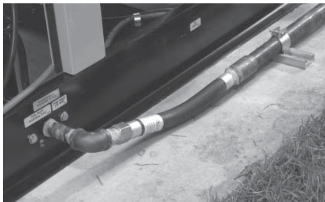
Рисунок 1.8. Гибкая топливная линия
