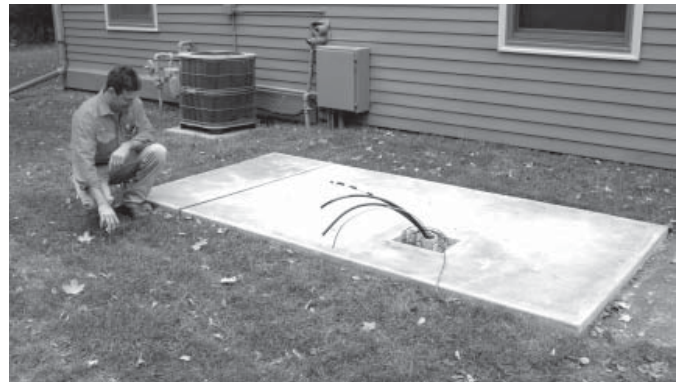
Figure 1.2 — Position Conduit
