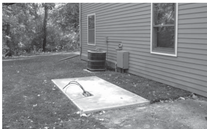
Figura 1.1 - Base de montagem
